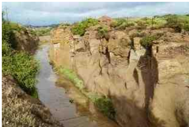
Figura 11_Particolare di un tratto del Canale di Guardia (settore settentrionale)
