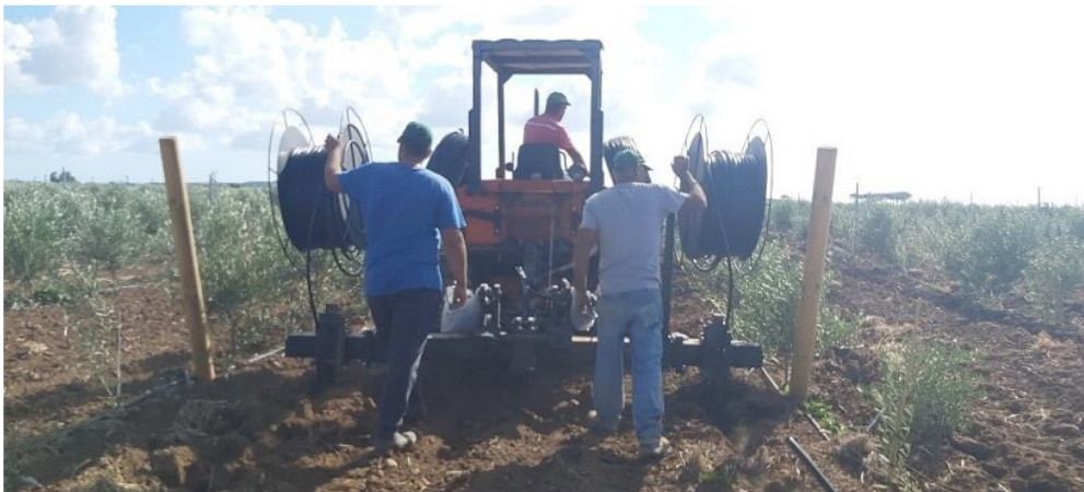
Posa delle tubazioni interrate (Maniscalco irrigazioni)
