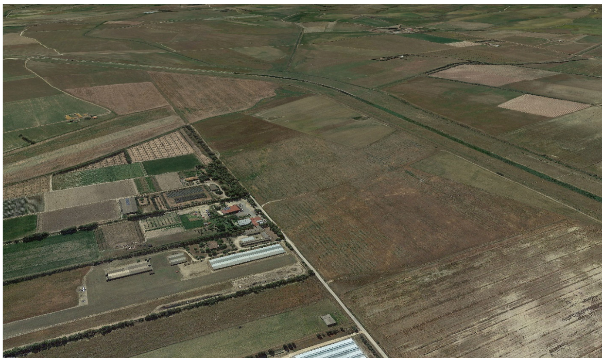
Foto 1 – panoramica Ante Operam
