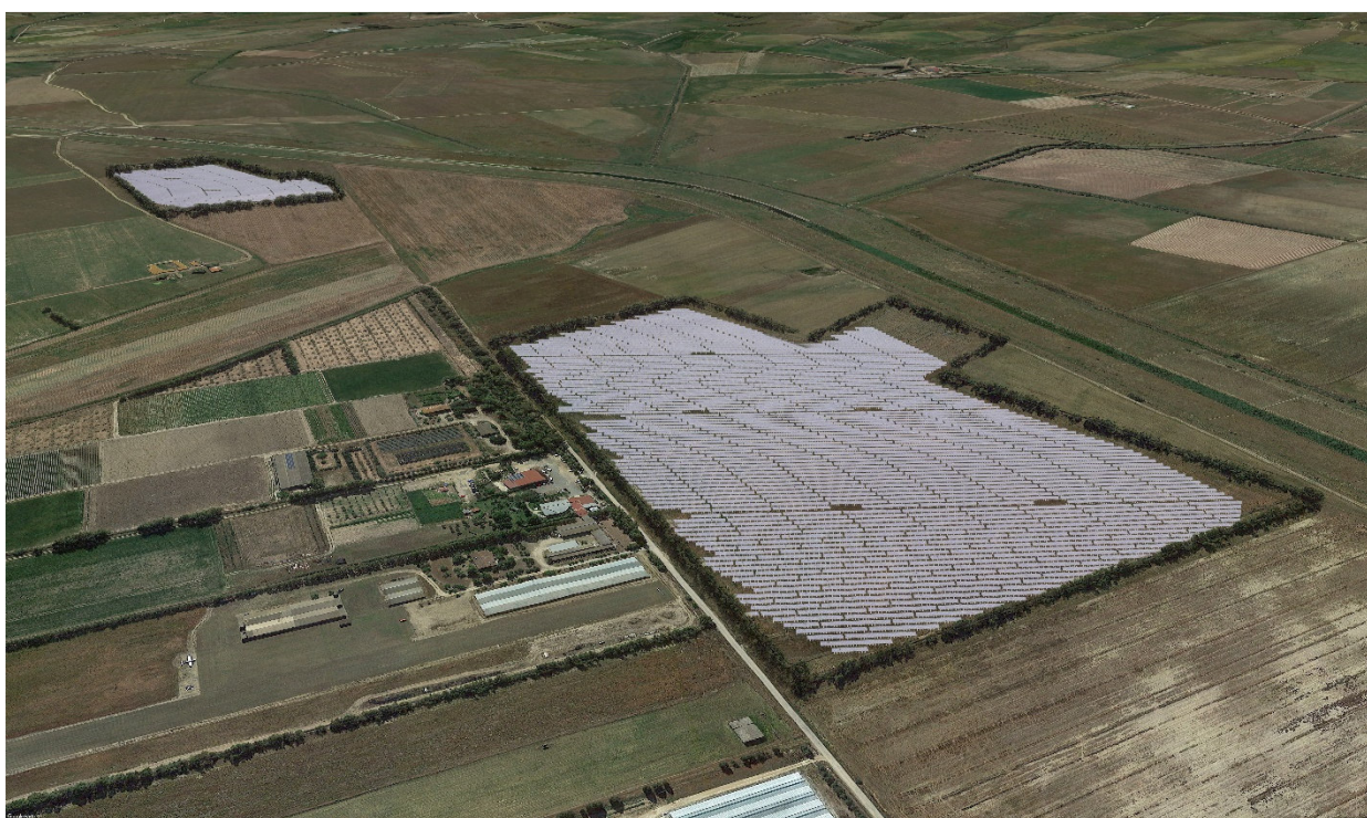
Foto 1 – panoramica Post Operam
