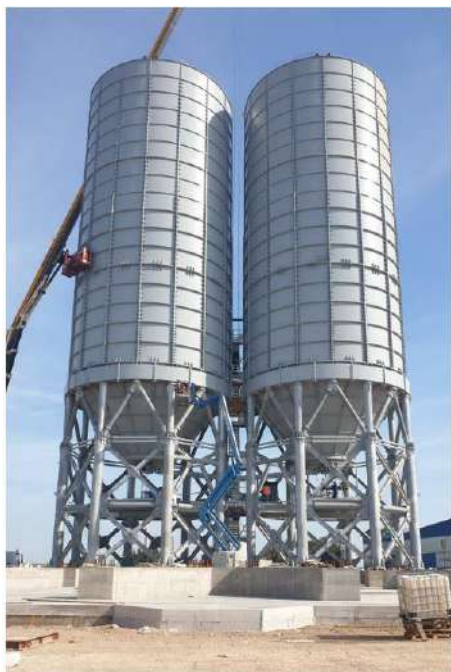
Figura 4-7: silos realizzati parte a terra impianto
