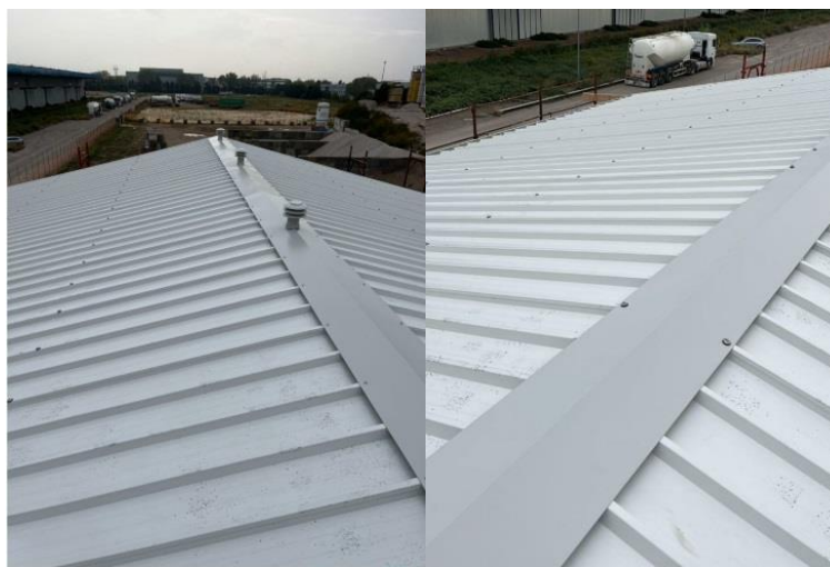
Figura 6-12: copertura edificio su cui è previsto il posizionamento del fotovoltaico
