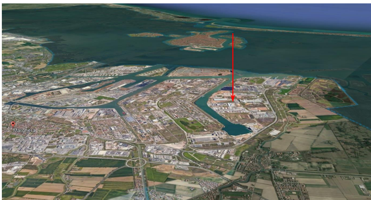
Figura 6-4: Vista aerea dell'intervento indicata con freccia rossa
