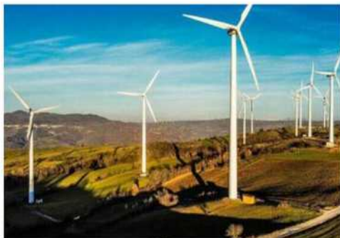
Un impianto eolico come quello che si vuole realizzare sul monte Miesola
