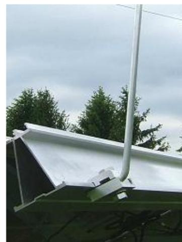
Viste punta di captazione con fissaggio tramite morsetto
