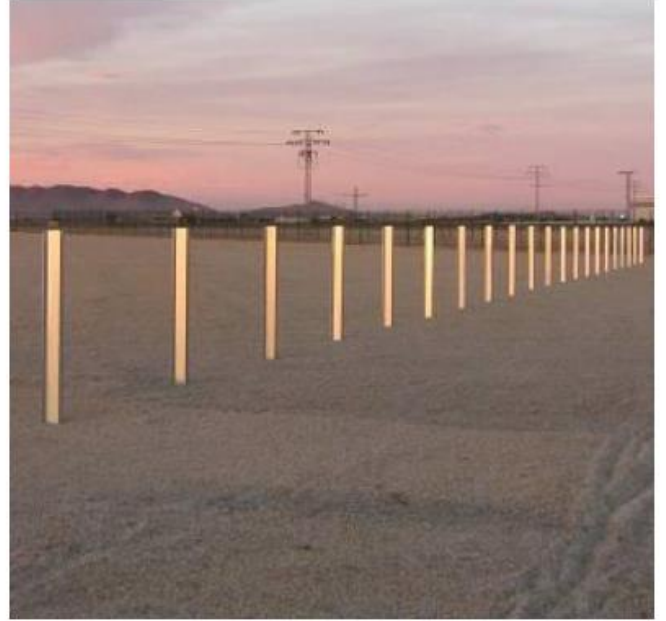
Fig.3 I pali di fondazione vengono infissi nel terreno e saranno estratti con estrema facilità e rapidità grazie all'utilizzo di mezzi appositamente progettati.
