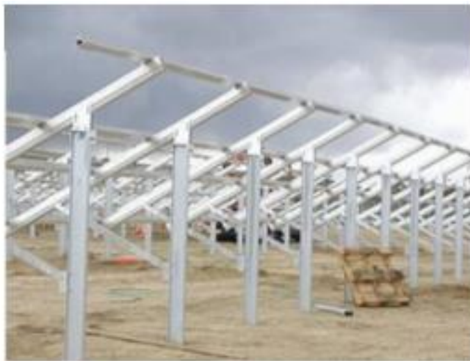
Fig. 2 Strutture di sostegno moduli completamente riciclabile e facilmente estraibili dal suolo in fase di dismissione.
