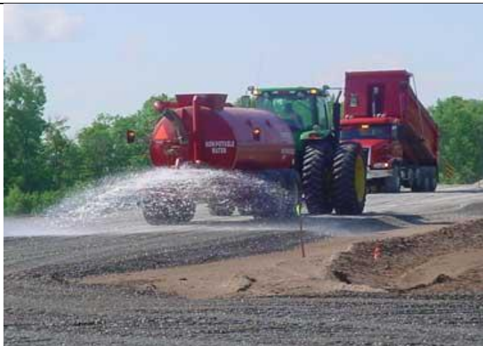
Figura 26 – Macchina per la bagnatura delle piste
