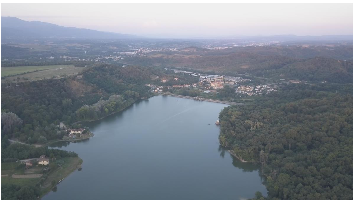
Figura 72 – Foto aerea della Diga di Santa Barbara o San Cipriano (fonte Google Earth)
