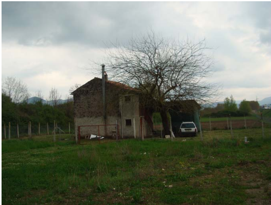
Fig. 4 – Edificio interferente da acquisire
