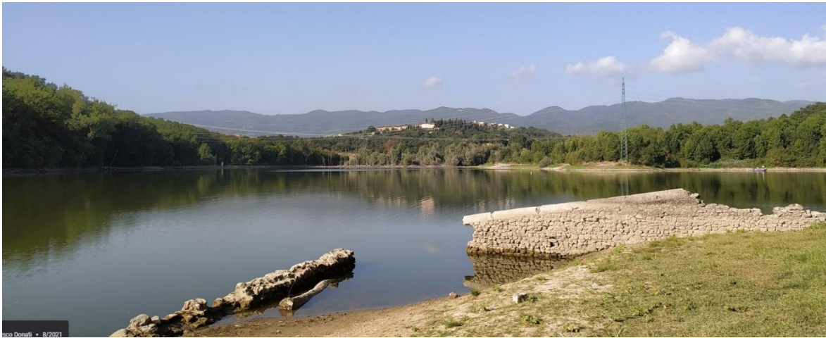
Figura 66 – foto dalla sponda della Diga di Santa Barbara o San Cipriano (fonte Google Earth)
