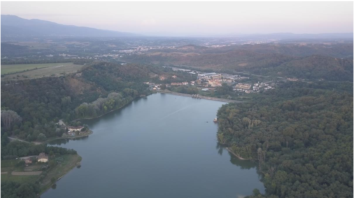
Figura 66 – Foto aerea della Diga di Santa Barbara o San Cipriano (fonte Google Earth)
