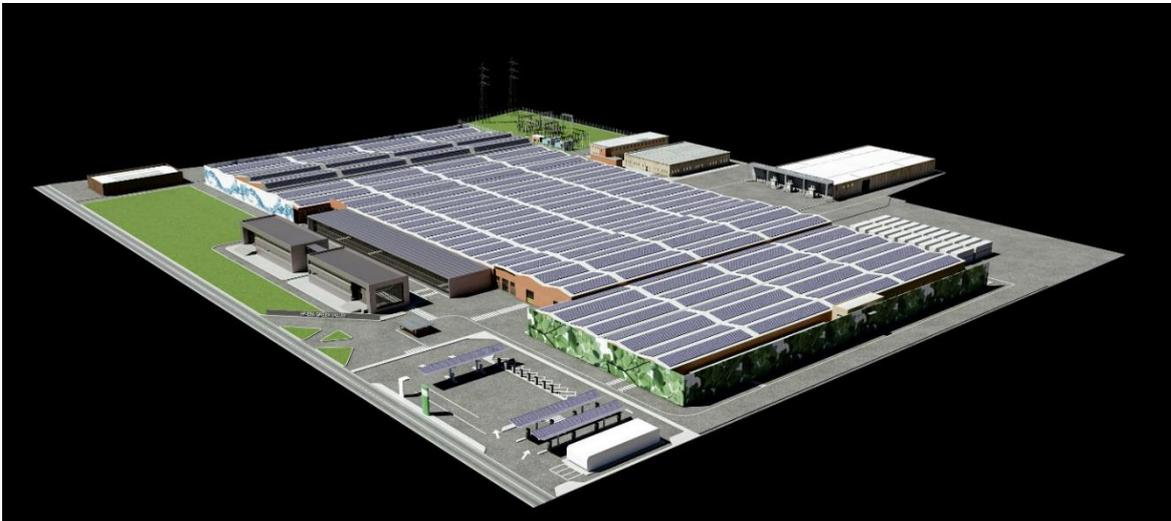
La superficie coperta dello stabilimento permette l'installazione di un impianto fotovoltaico di potenza pari a 7 MWp), a cui si aggiungono le aree esterne alla proprietà, 483.900 m<sup>2</sup> totali, individuate per l'installazione di ulteriori 84 MWp fotovoltaici.
