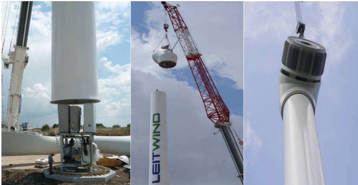
Foto 6 -Montaggio torre
