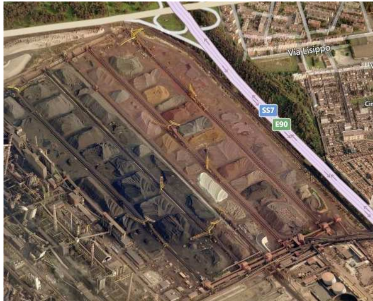
Vista panoramica dei parchi esistenti da coprire
