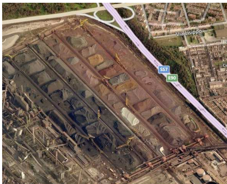
Vista panoramica dei parchi esistenti da coprire
