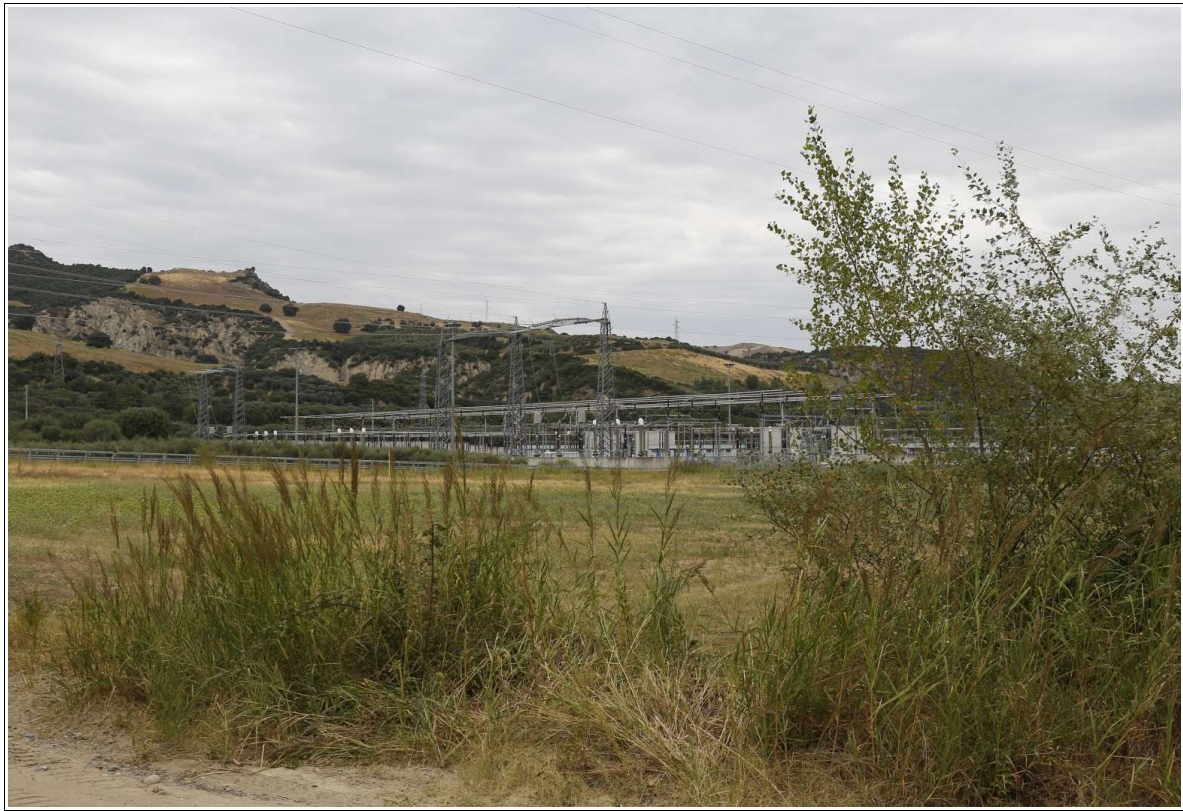
Figura 36 – Veduta della stazione elettrica di servizio in territorio di Aliano (Foto Studio Rocco Carella).
