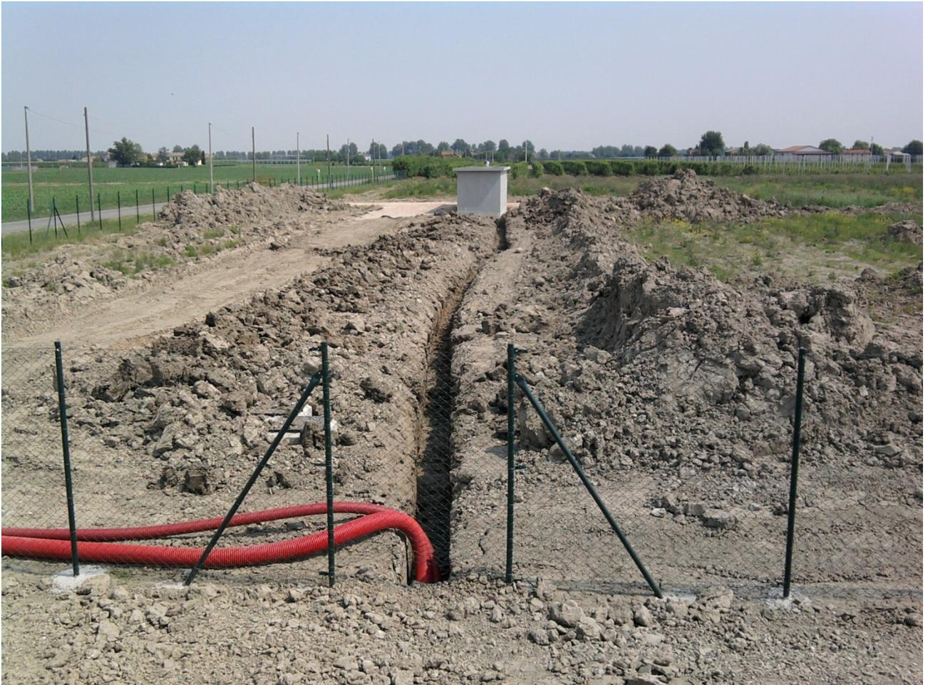
Figura 6 | Tipico di realizzazione di cavidotto interrato
