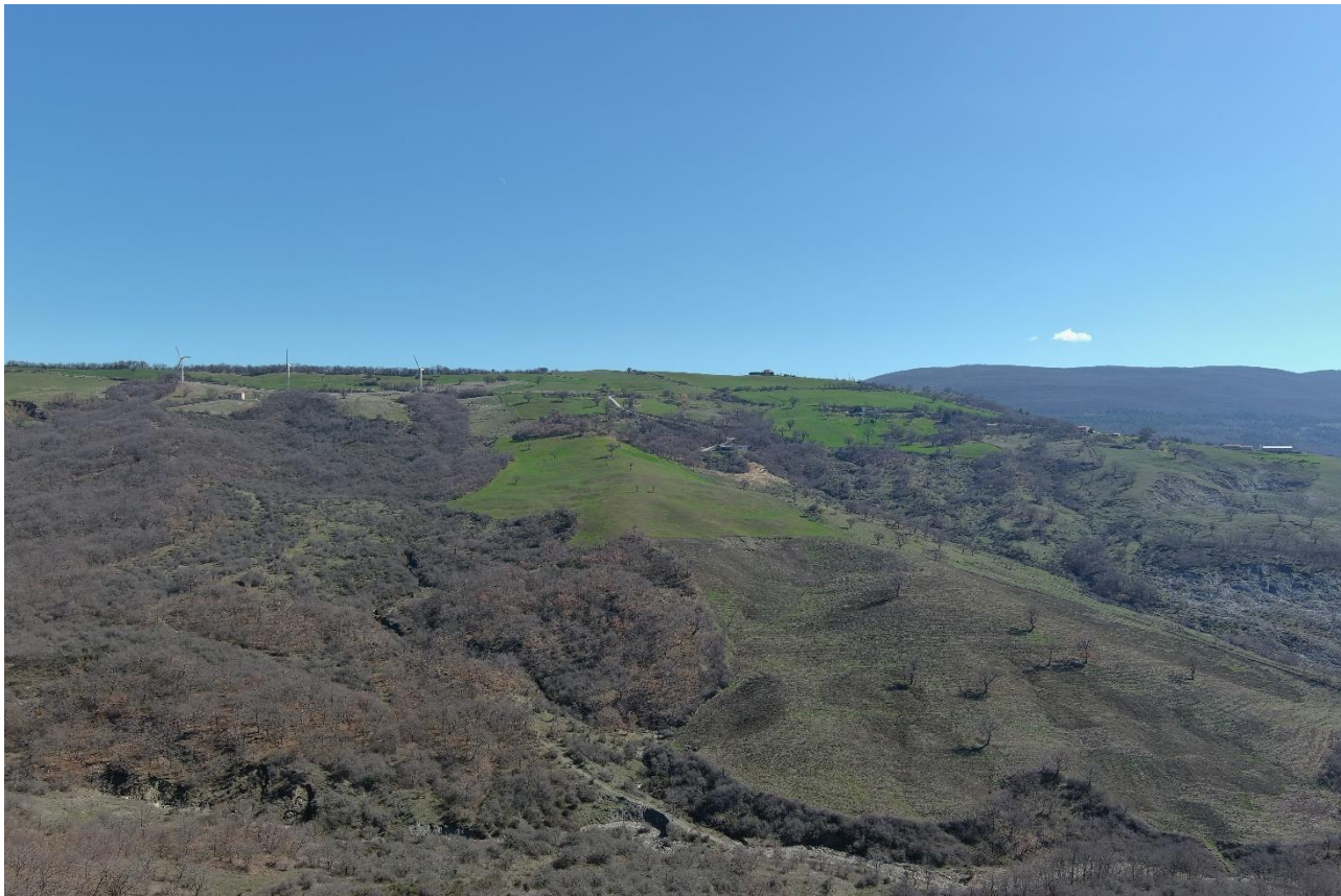
Foto 2: Vista su strada ingresso area piazzola di montaggio aerogeneratore AL03
