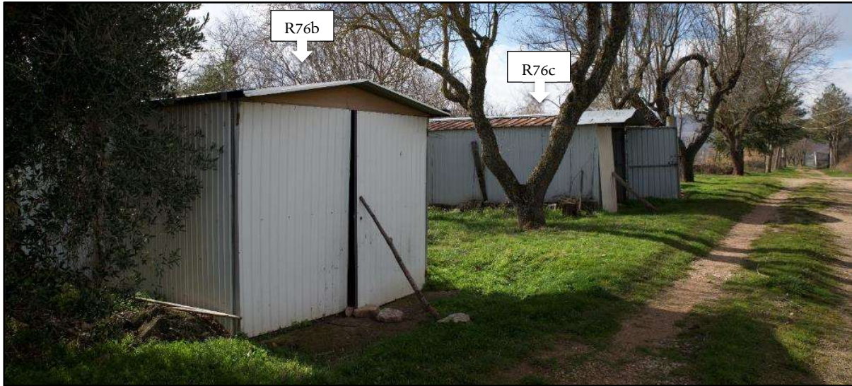
Foto 62a: R76b-Magazzino; R76c-Magazzino
