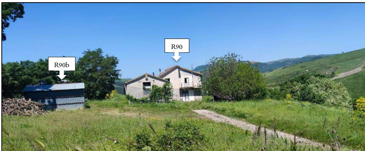
Foto 74a: R90-Magazzino; R90b-Magazzino
