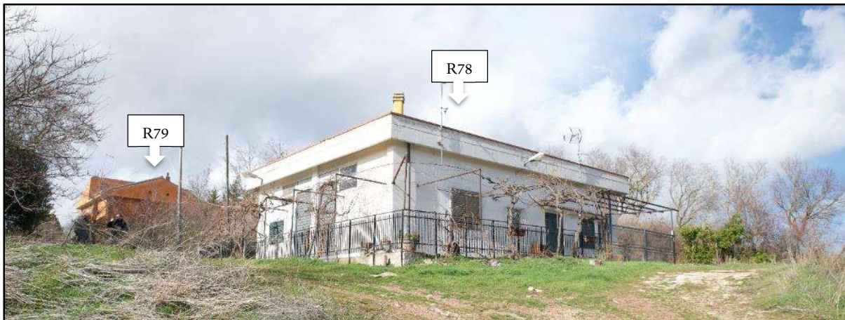
Foto 64a: R78-Abitazione; R79-Abitazione
