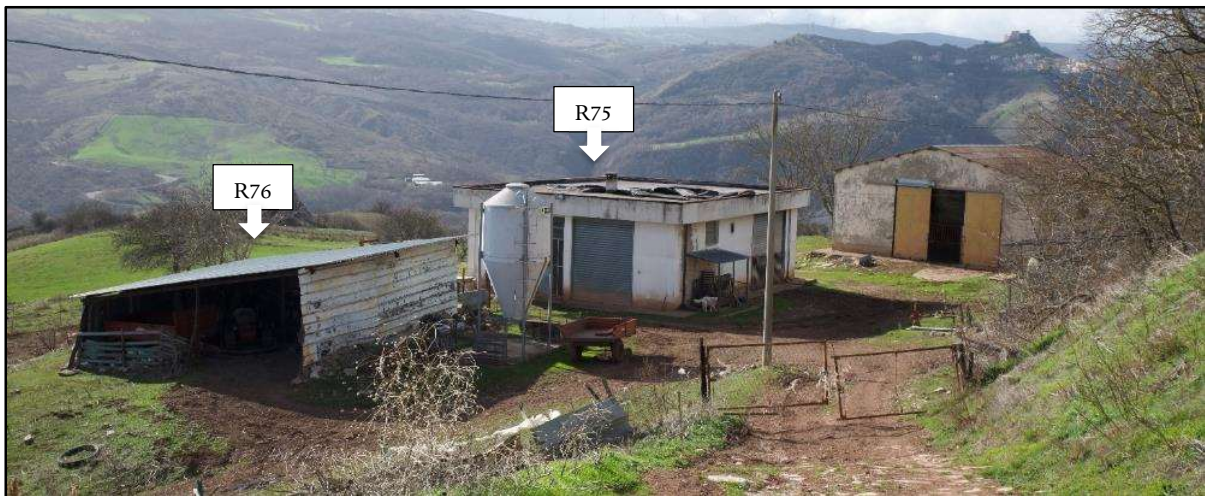
Foto 60b: R75-Magazzino; R76-Magazzino
