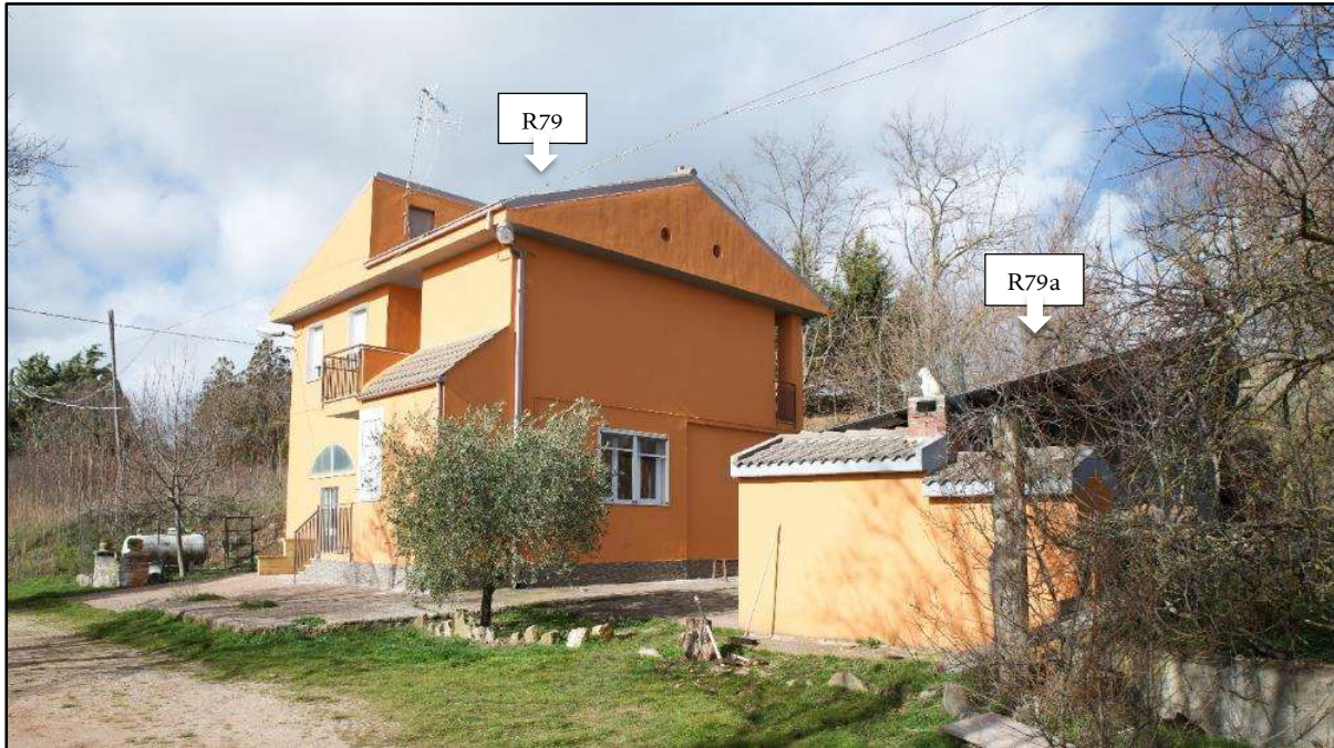
Foto 65a: R79-Abitazione; R79a-Funzioni Produttive
