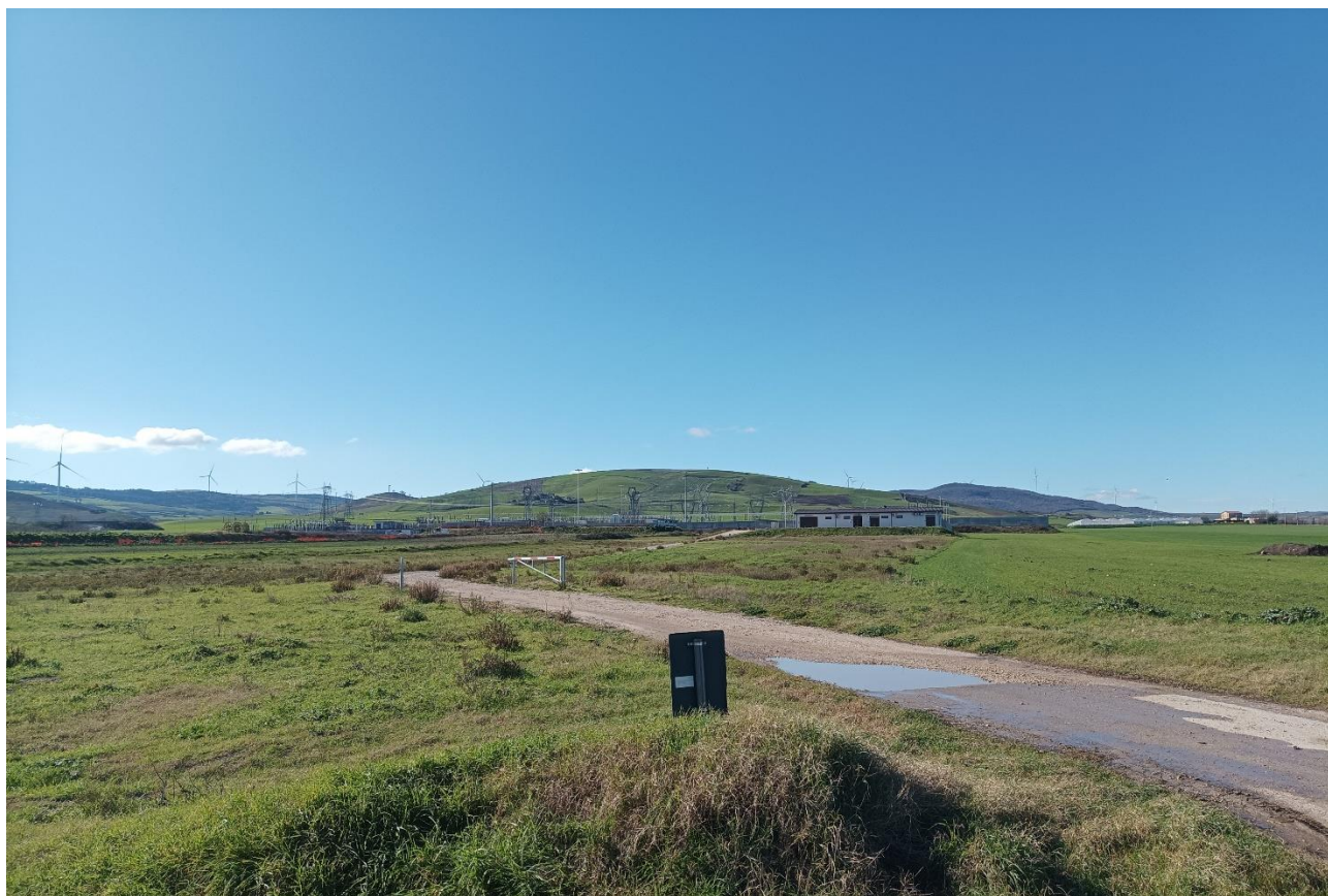
Foto 7: Vista su area ampliamento SE RTN
