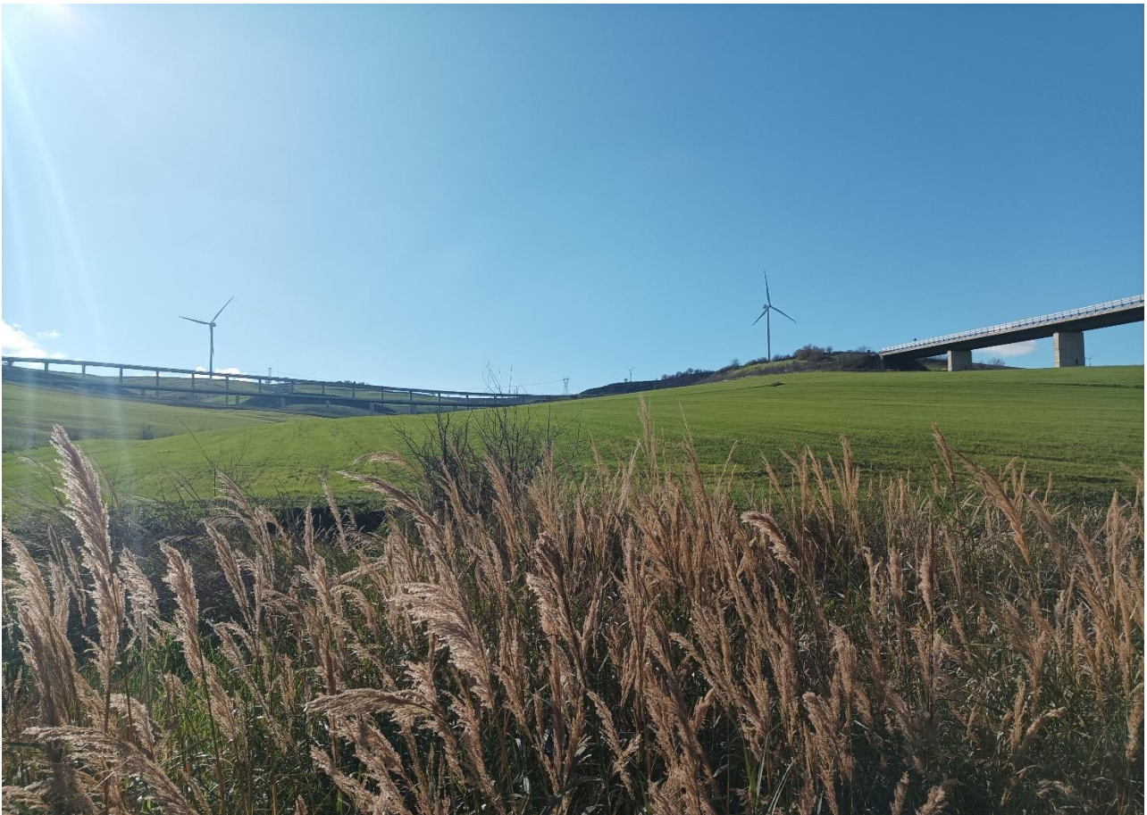
Foto 5: Vista su strada ingresso area piazzola di montaggio aerogeneratore ML06
