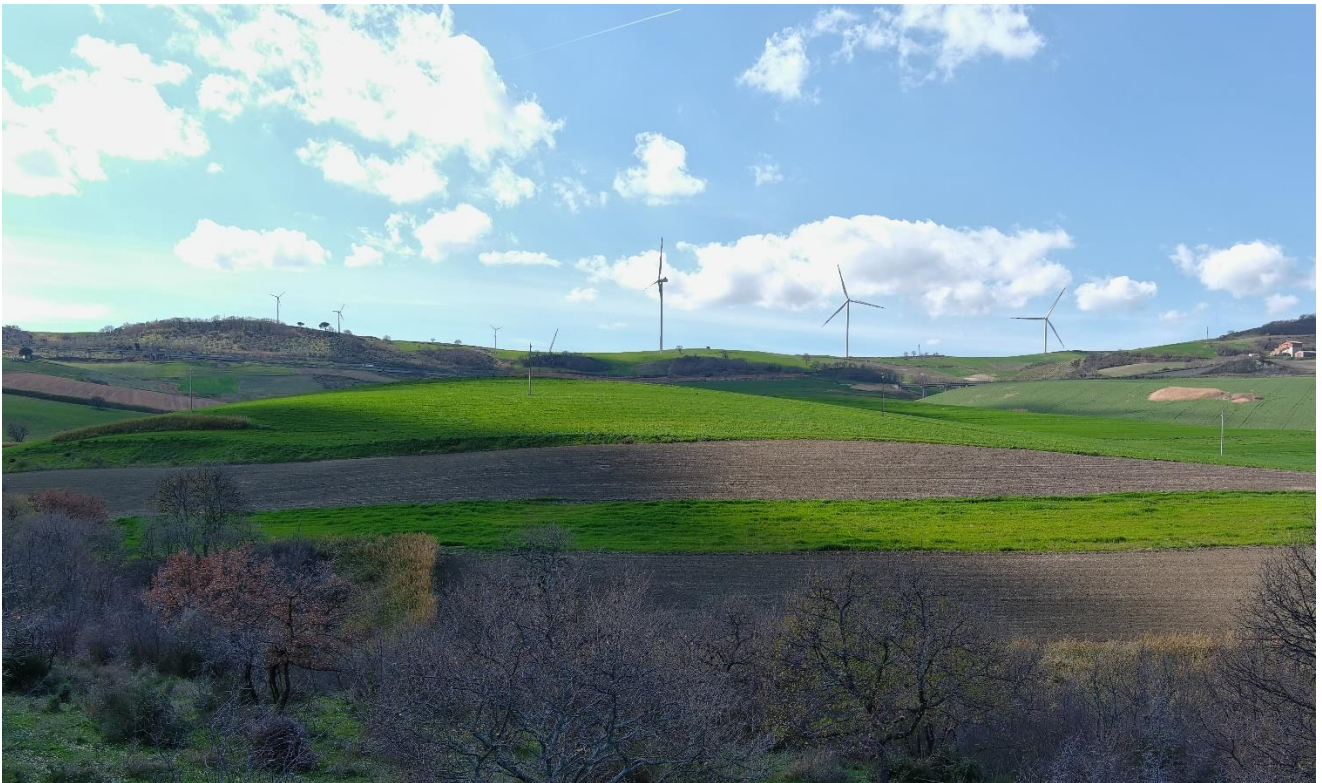
Foto 3: Vista su strada ingresso area piazzola di montaggio aerogeneratore ML04
