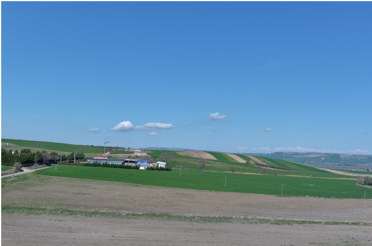
Foto 1: Vista su strade ingresso aree piazzole di montaggio aerogeneratori ML01
