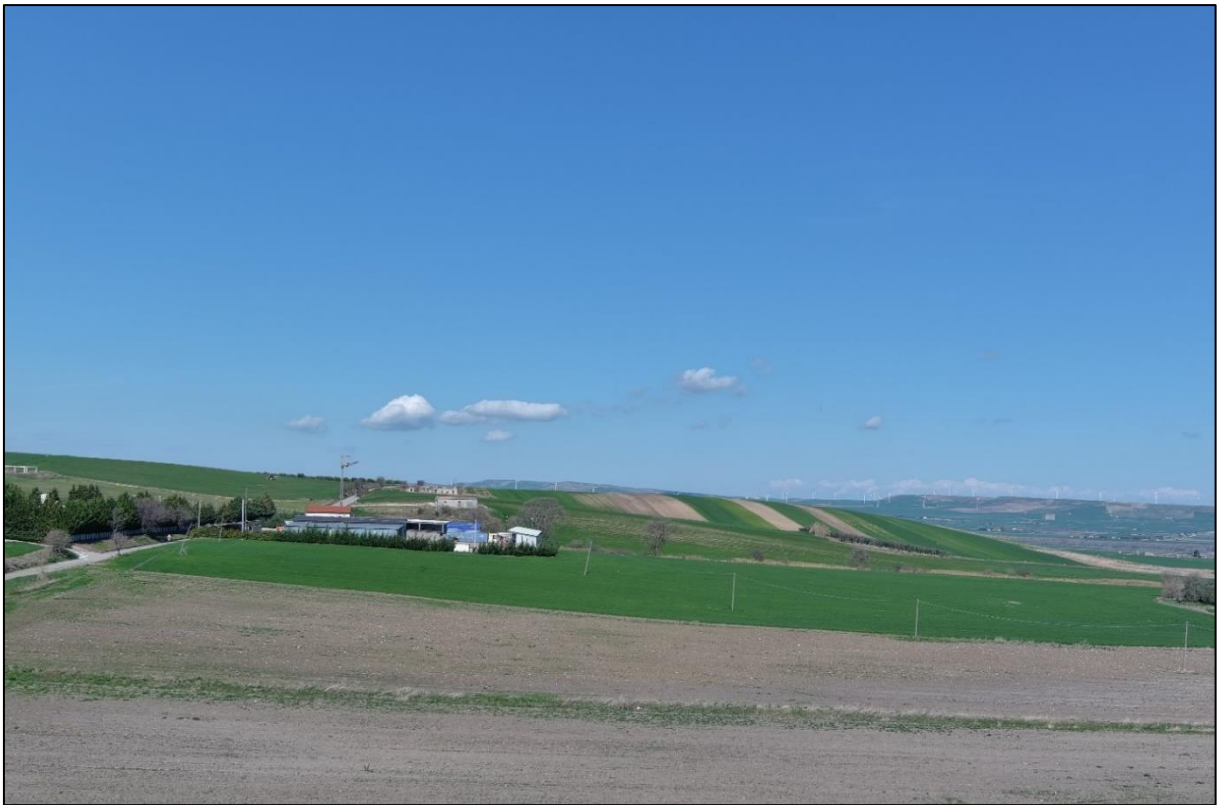
Foto 9.1: Vista su strade ingresso aree piazzole di montaggio aerogeneratori ML01
