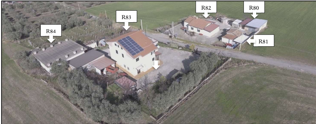
Foto 41b: R80-Funzioni Produttive; R81-Funzioni Produttive; R82-Abitazione; R83-Abitazione; R84-Funzioni Produttive
