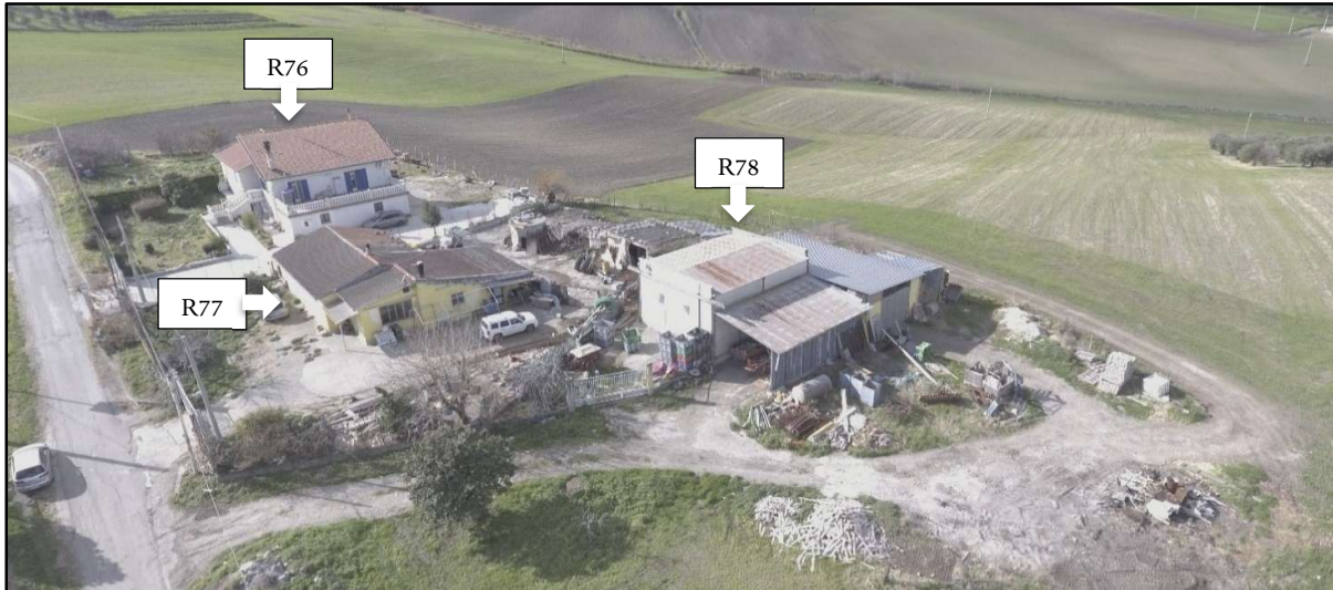
Foto 39a: R76-Abitazione; R77-Abitazione; R78-Funzioni Produttive
