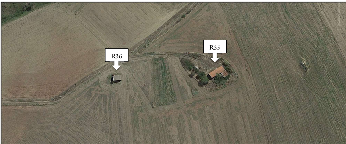
Foto 22a: R35-Magazzino; R36-Magazzino (Ricettori non accessibili)
