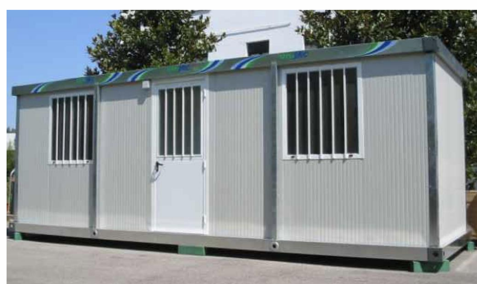
Dettaglio 4 - Container ad uso wc e docce
