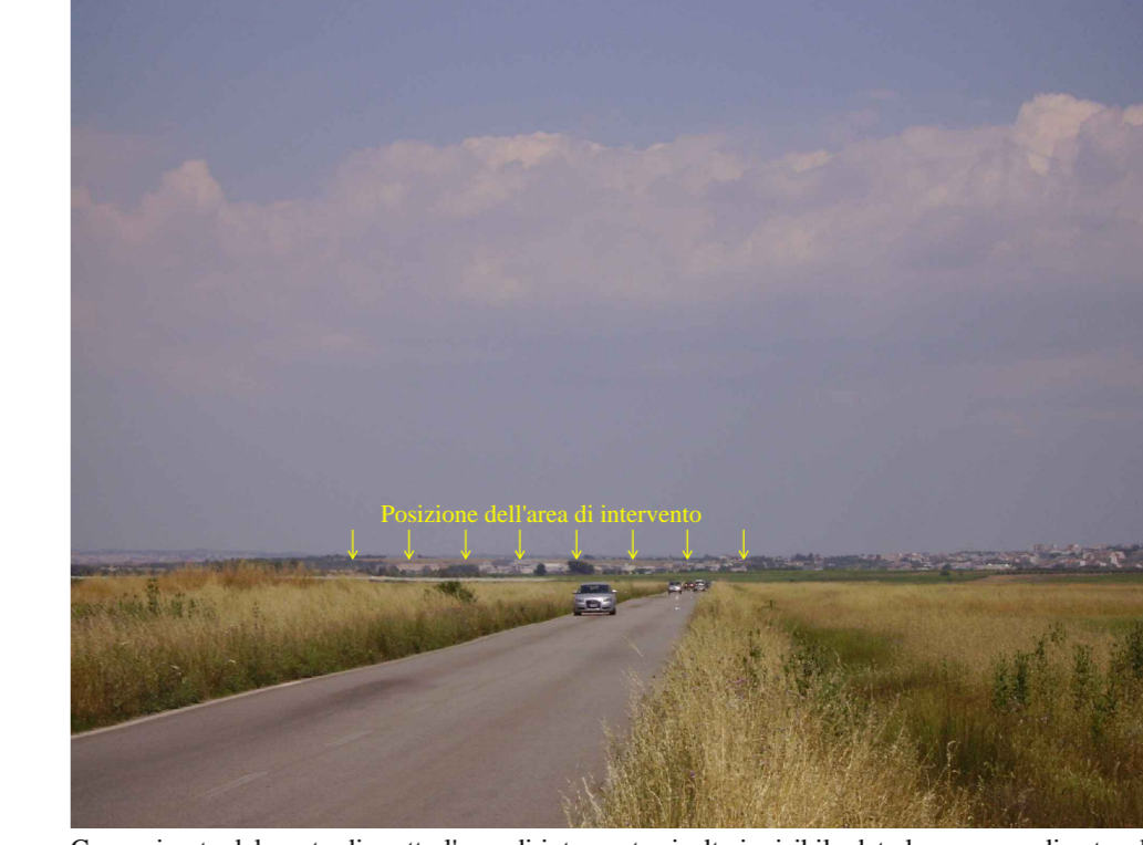
Foto n. 24: S.P. 104 della Salina Grande (presso ripetitore RAI)
