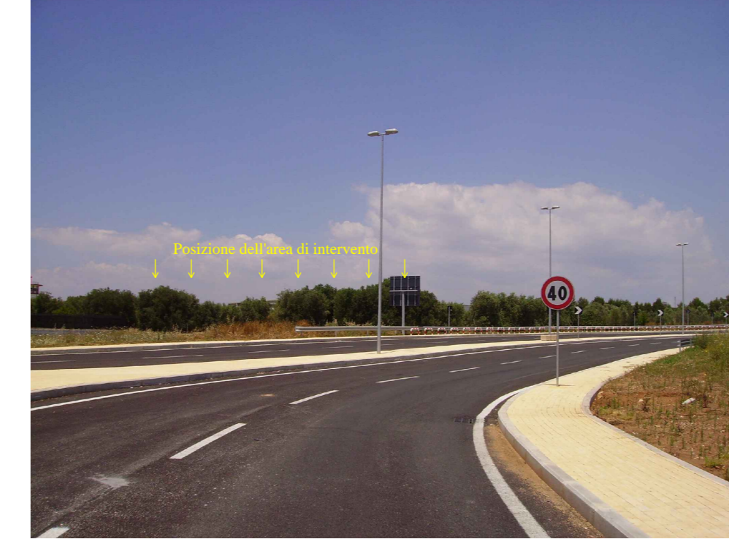
Foto n. 17: S.S. 7 (presso stazione di servizio Q8)
