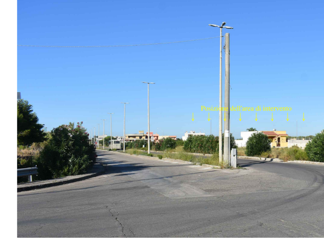
Foto n. 8: Intersezione S.P. 81 - Via Olimpia (presso stadio Carosino)
