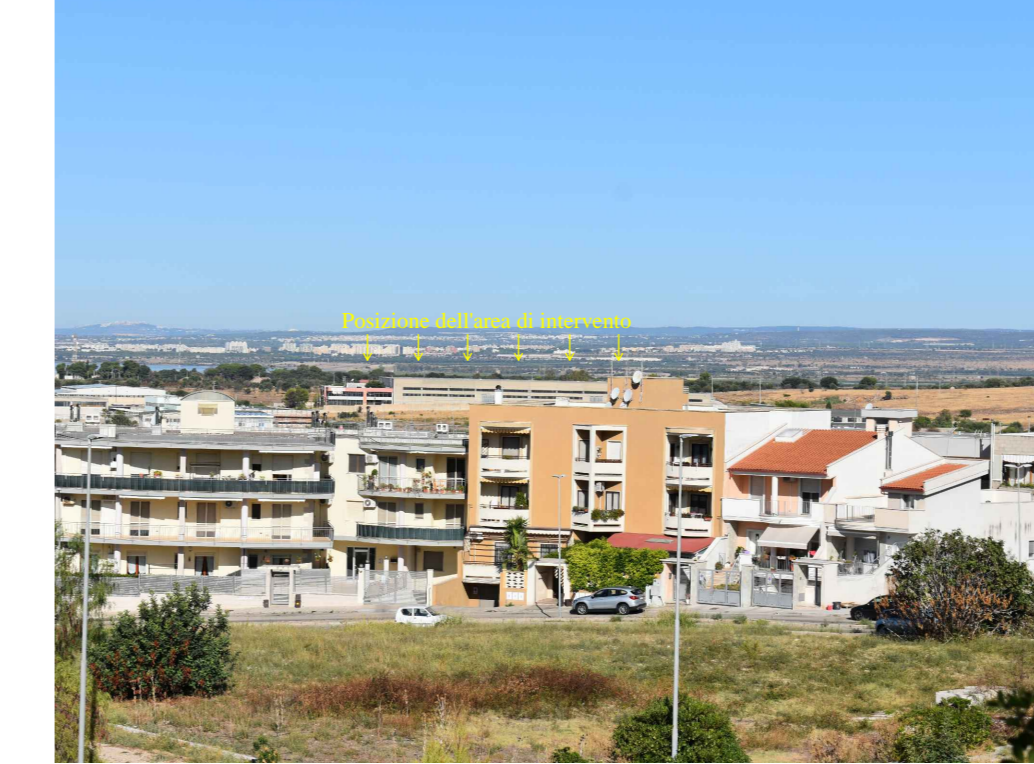
Foto n. 18: Intersezione Via Petrarca - Via Moscatelli (abitato di S. G. Jonico)
