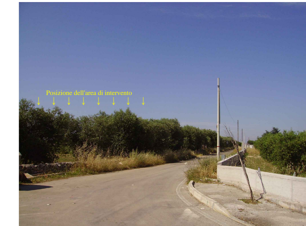
Foto n. 4: Intersezione S.P. 80 - Via Battendieri (presso cimitero Monteiasi)
