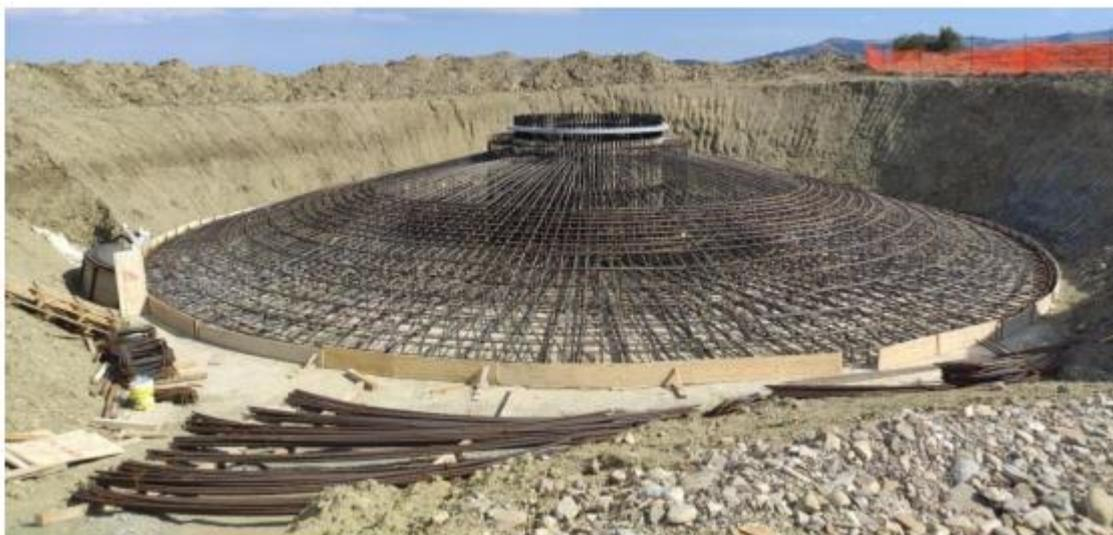
*Figura 9 - Armatura plinto tipo*
