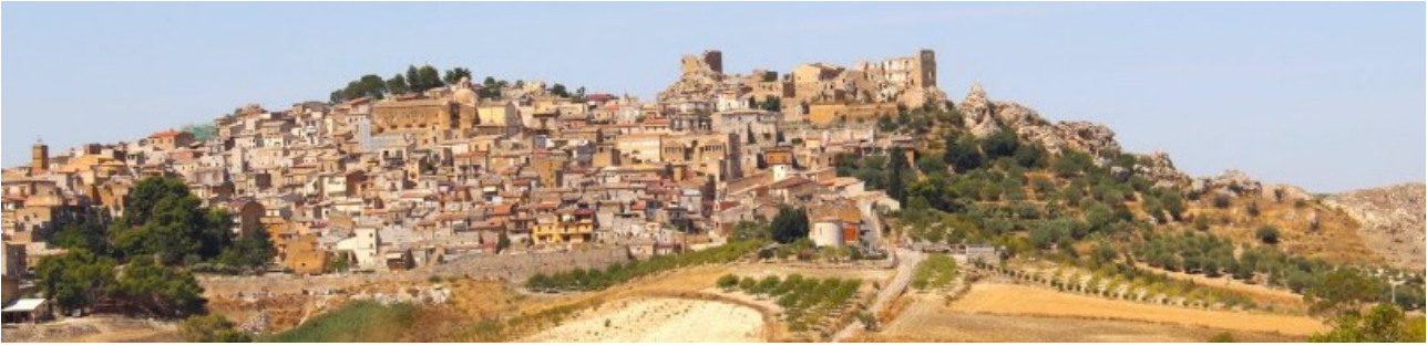
Fig 2. Ripresa fotografica dell'abitato del comune di Pietraperzia
