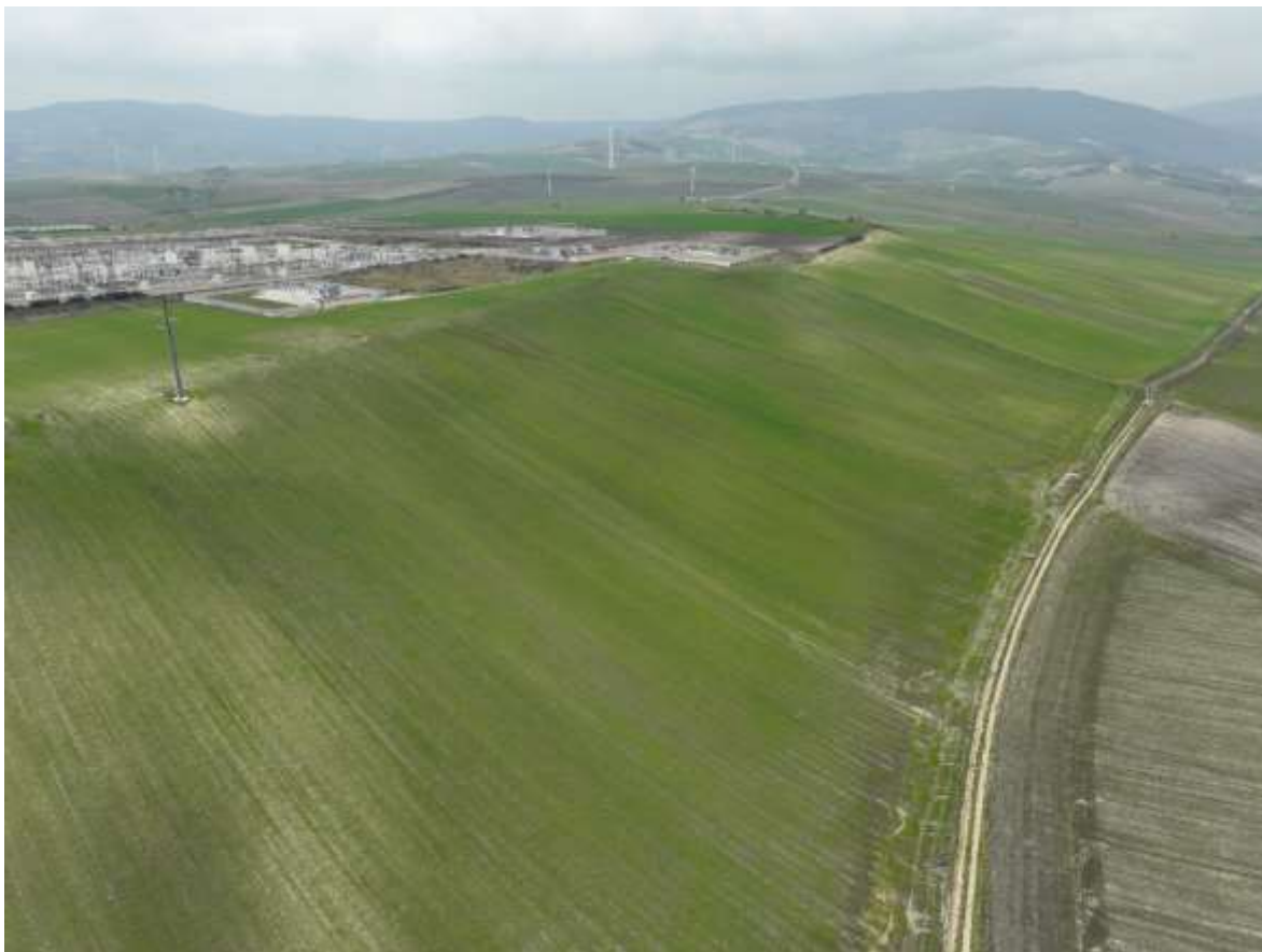
Figura 4 - Area di ampliamento SSE RTN Terna S.p.A.
