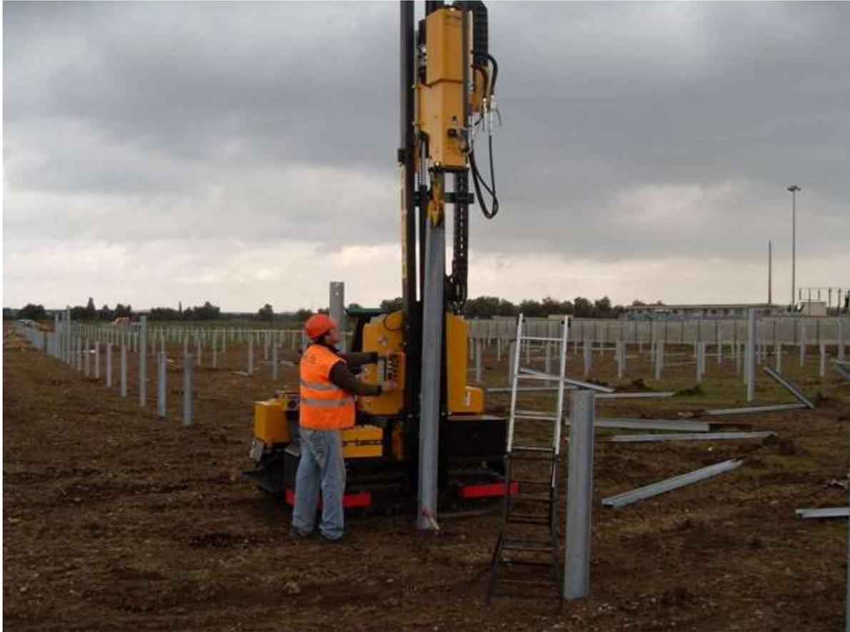
Figura 10 - Modalità di posa dei pali con macchina battipalo
