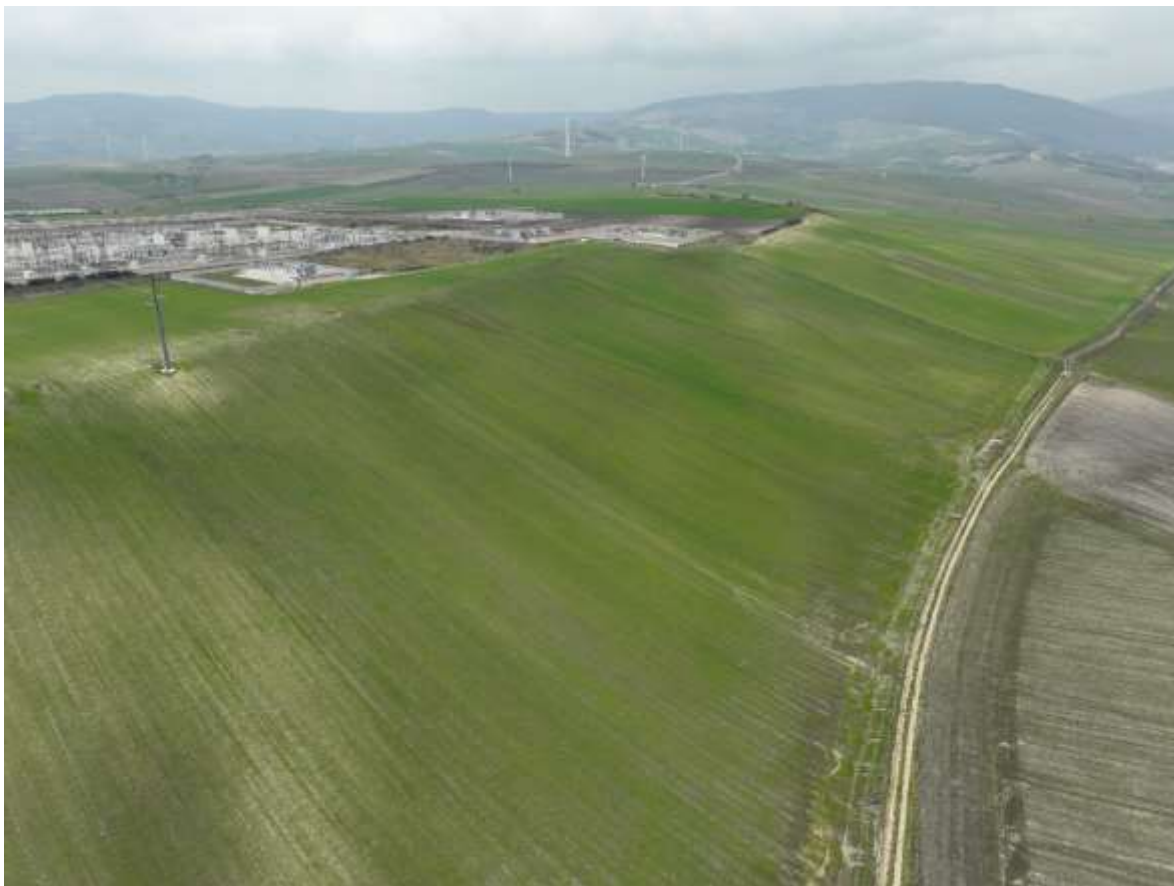
Figura 4 - Area di ampliamento SSE RTN Terna S.p.A.
