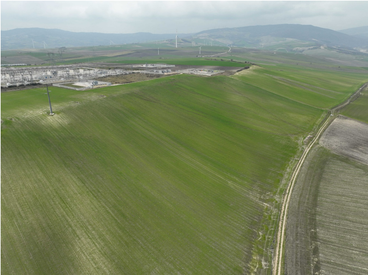
Figura 4 - Area di ampliamento SSE RTN Terna S.p.A.
