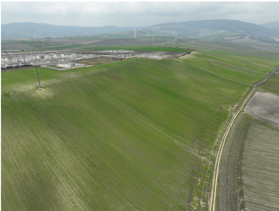
Figura 4 - Area di ampliamento SSE RTN Terna S.p.A.
