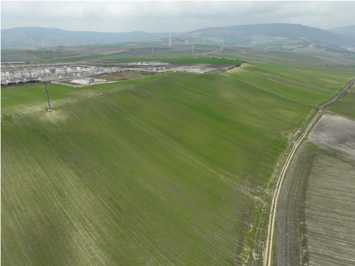
Figura 4 - Area di ampliamento SSE RTN Terna S.p.A.
