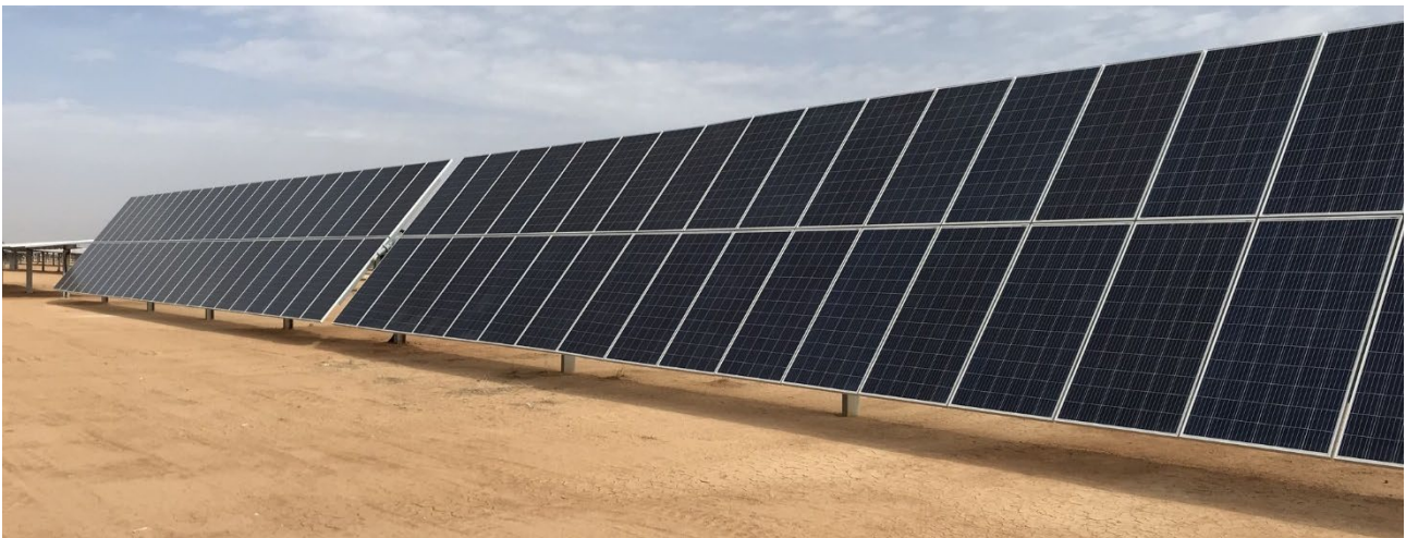
Figura 21 - Inseguitore monoassiale vista frontale
