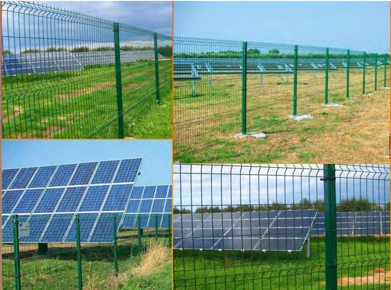
Figura 51 - Recinzione perimetrale - dettaglio costruttivo
