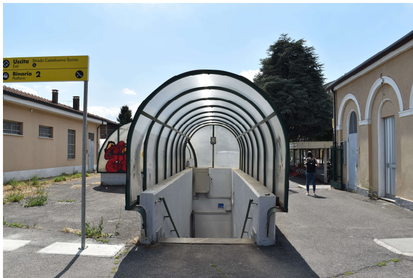
Ingresso laterale e accesso al sottopasso
