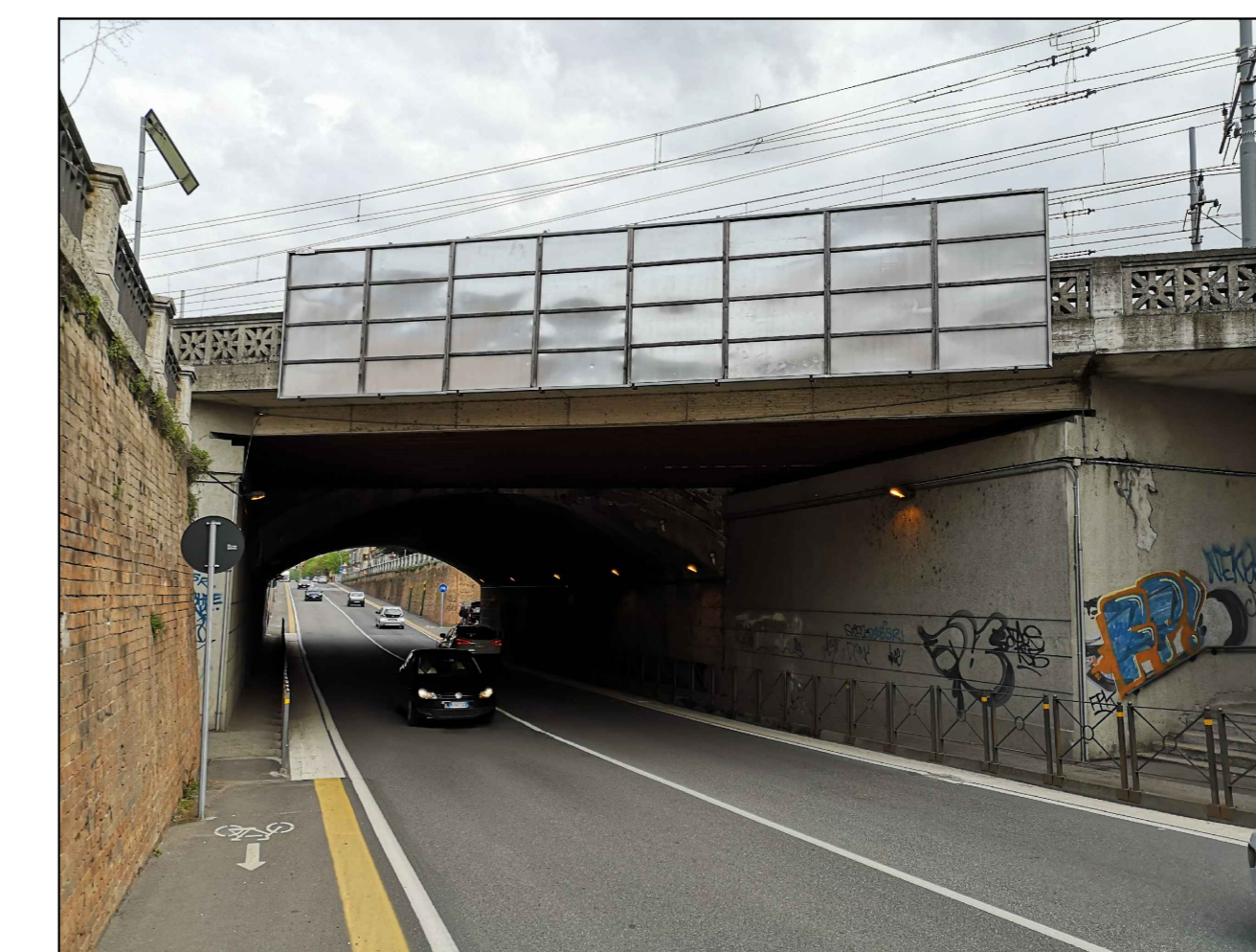
FOTO PROSPETTO LATO VIA LOMELLINA
