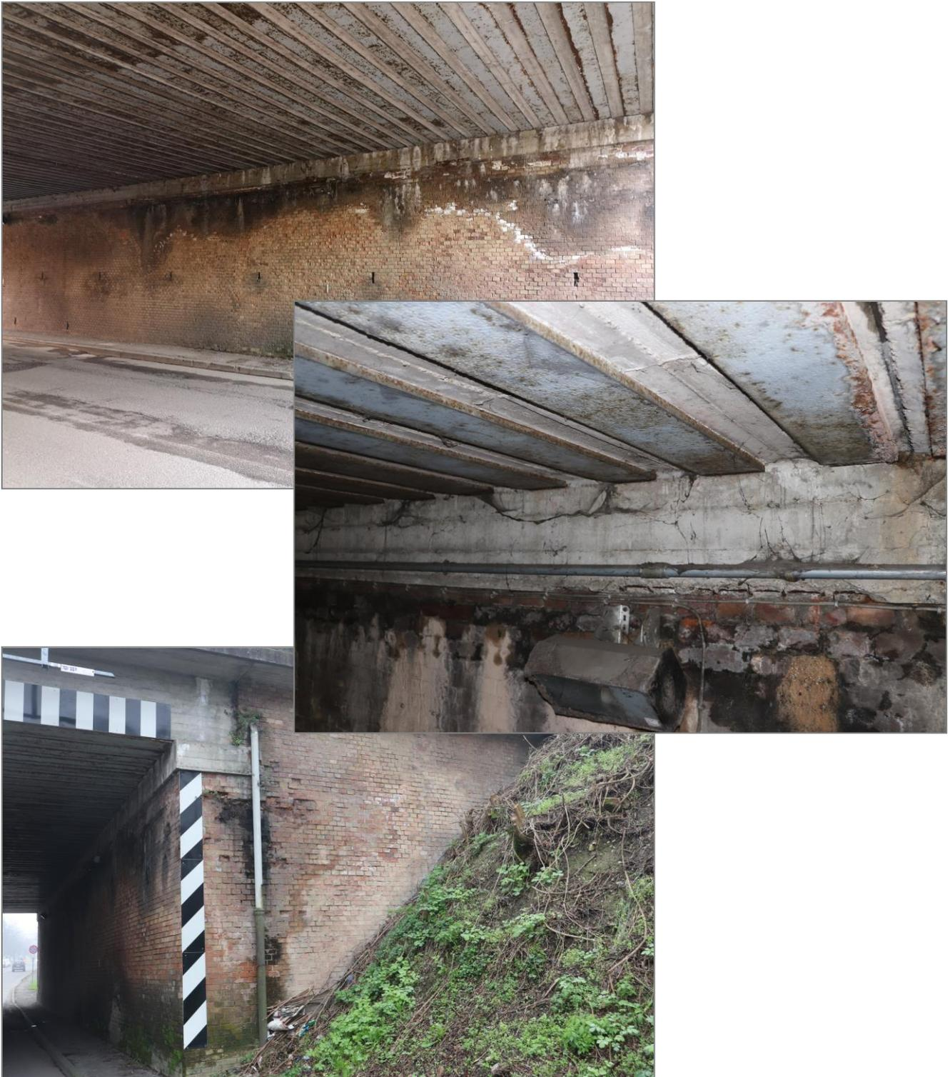
Figura 8 – Ponte ferroviario esistente su via Baxilio: ammaloramenti
