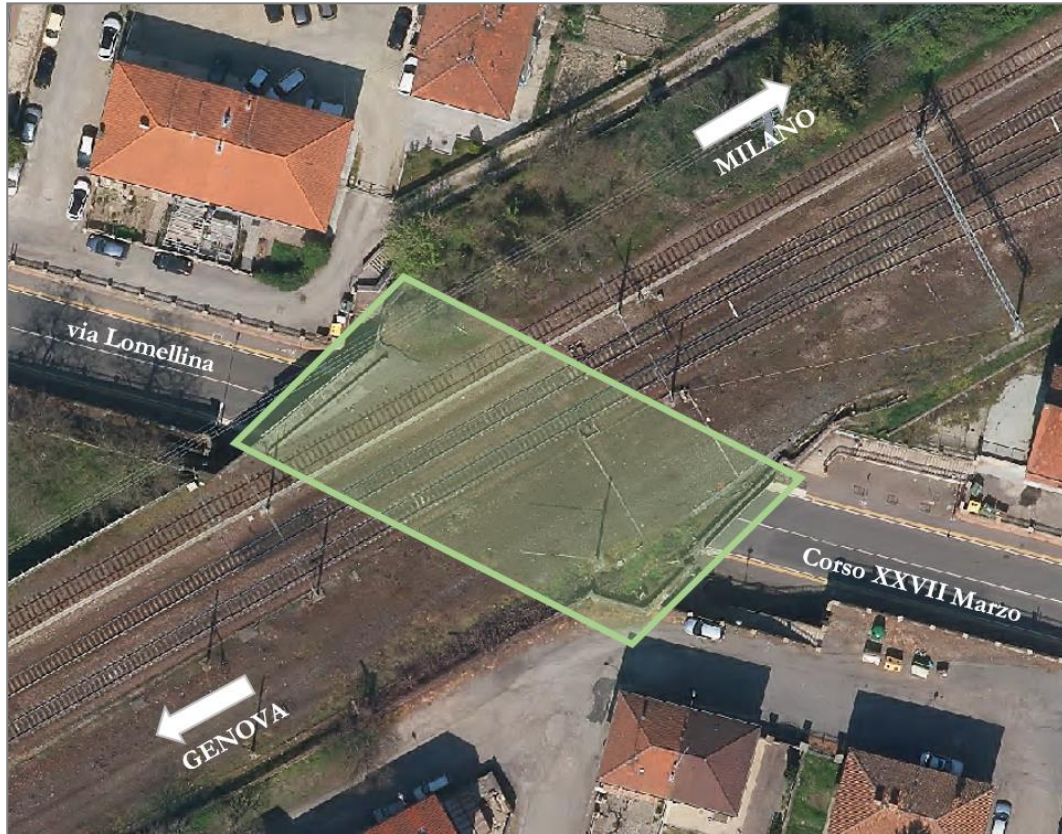
Figura 1 – Ponte ferroviario esistente su Corso XXVII Marzo/ via Lomellina: stralcio planimetrico con ubicazione
