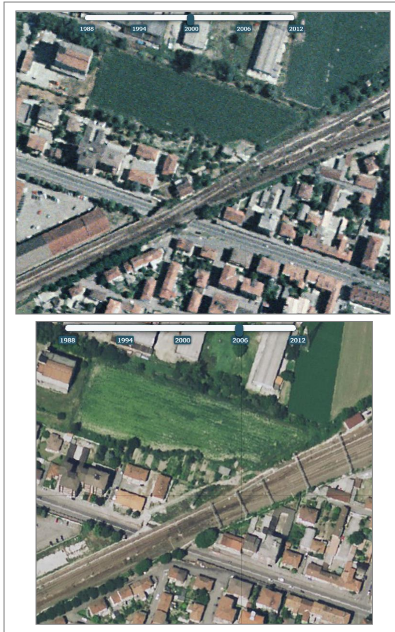
Figura 7 – Ponte ferroviario esistente su Corso XXVII Marzo/ via Lomellina: viste aeree anno 2000 ed anno 2006 (da sito http://www.pcn.minambiente.it/viewer/ )
