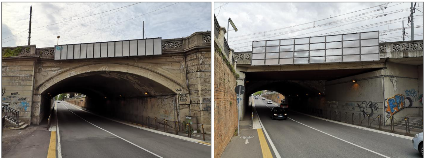
Figura 2 – Ponte ferroviario esistente su Corso XXVII Marzo/ via Lomellina: prospetto lato Corso XXVII Marzo (foto sx) e prospetto lato via Lomellina (foto dx)
