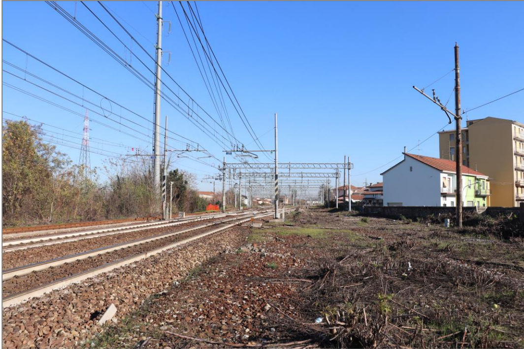
Figura 6 – Ponte ferroviario esistente su Corso XXVII Marzo/via Lomellina: vista verso Milano della piattaforma ferroviaria in corrispondenza del ponte con evidenza di sostegni TE dismessi lato Corso XXVII Marzo
