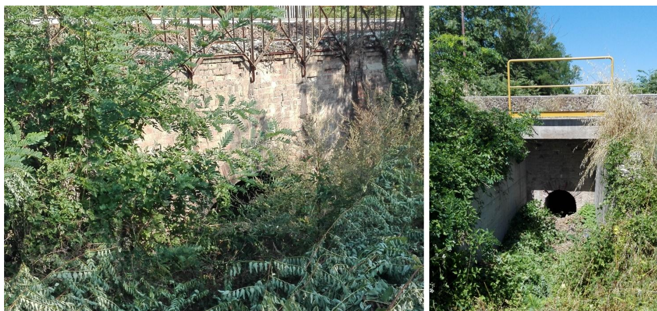
Figura 10: Torrente Calvenza: opera FS di attraversamento esistente
