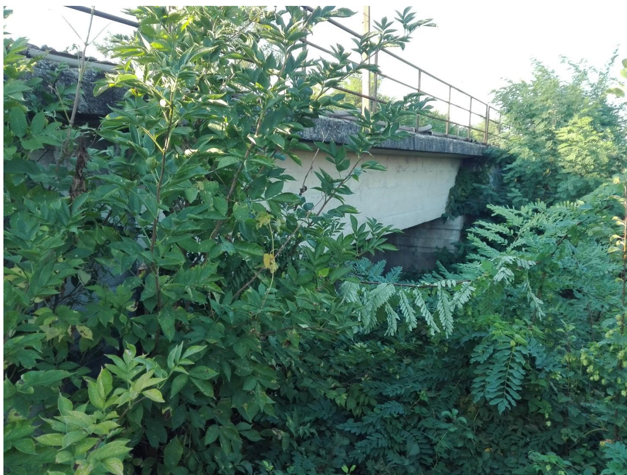
Figura 7: Torrente Grue: opera FS di attraversamento esistente
