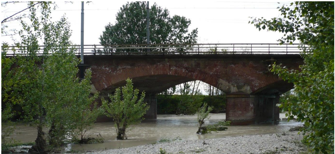
Figura 5: Torrente Curone: opera FS di attraversamento esistente
