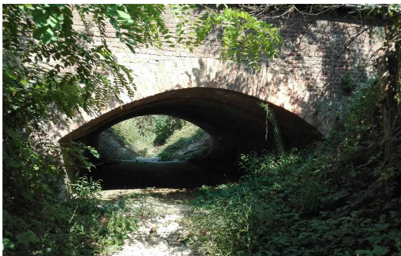
Figura 8: Torrente Limbione: opera FS di attraversamento esistente
