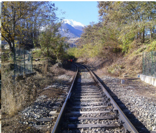
Impianto lubrificazione P.A.L. Italia (Foto: P.A.L. Italia; 2012)
