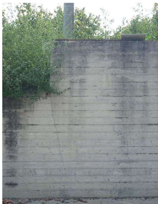
Particolare fessura muro contro terra di recente costruzione
