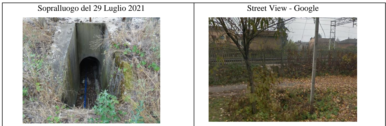
Figura 6.4: Attraversamento pk 63+853km
