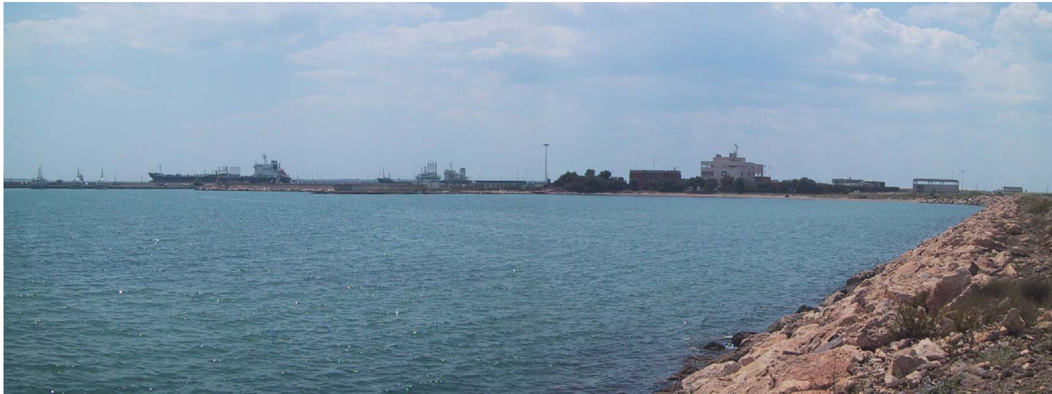
Foto 4 Vista della Darsena – lato intervento
