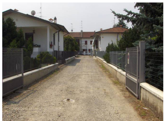
- Accesso lato nord –fabbr. fg. 51 mapp. 240 - 473
