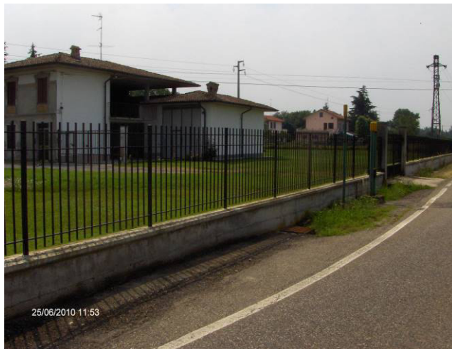
- Accesso lato ovest –fabbricato fg. 51 mapp. 140
