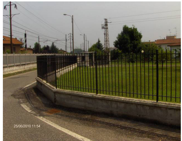
- Accesso lato nord –fabbricato fg. 51 mapp. 140
