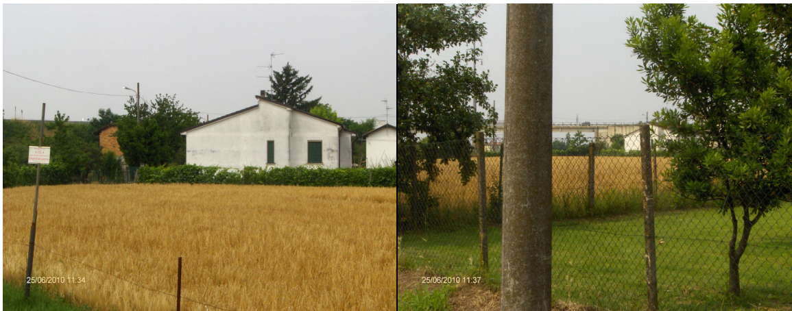
- Vista lato sud –fabbricato fg. 50 mapp. 416 - Vista lato est – fabbricato fg. 50 mapp. 168
