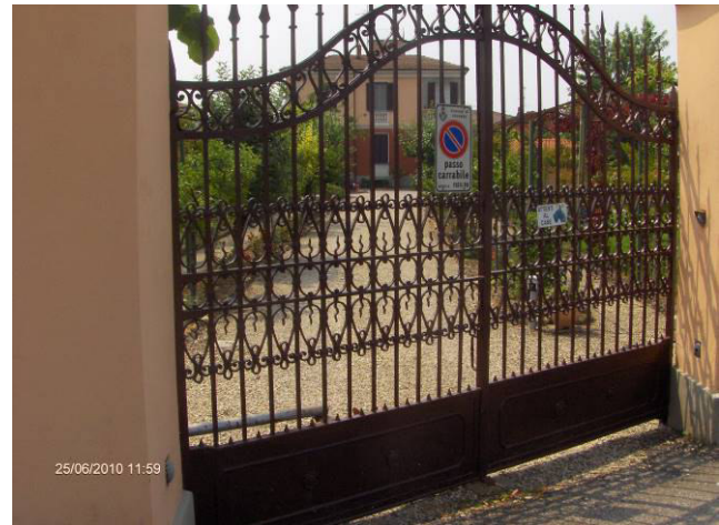
- Accesso lato nord -fabbricato fg. 51 mapp. 41
