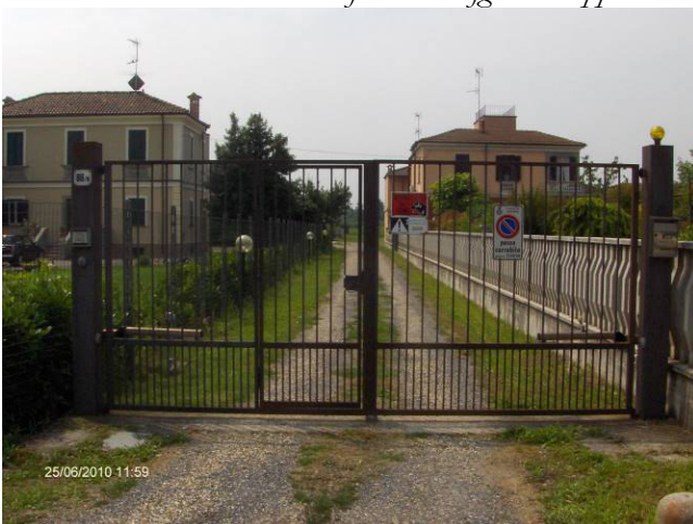
- Accesso lato nord -fabbr. fg. 51 mapp. 312 - 313
