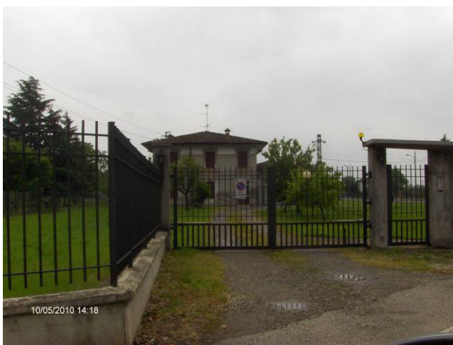
- Accesso lato nord –fabbr. fg. 51 mapp. 140
