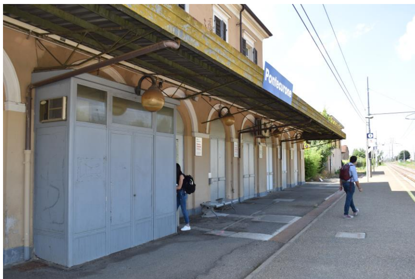
Figura 6 – Pensilina metallica, lato I marciapiede
