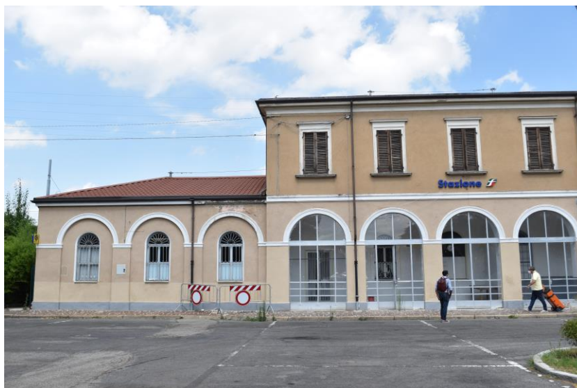
Figura 3 – Fabbricato viaggiatori prospetto principale lato piazzale
