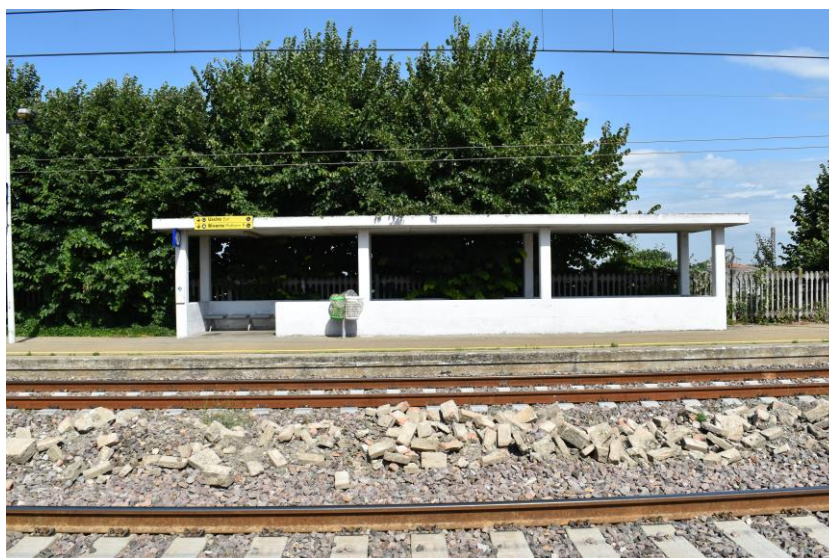
Figura 8 – Pensilina esistente II marciapiede
