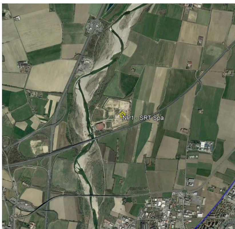
Figura 11: S.R.T. Spa Foto aerea dell'impianto
