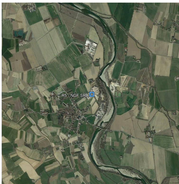
Figura 7: Foto aerea dell'impianto di Casal Cermelli (AL)
