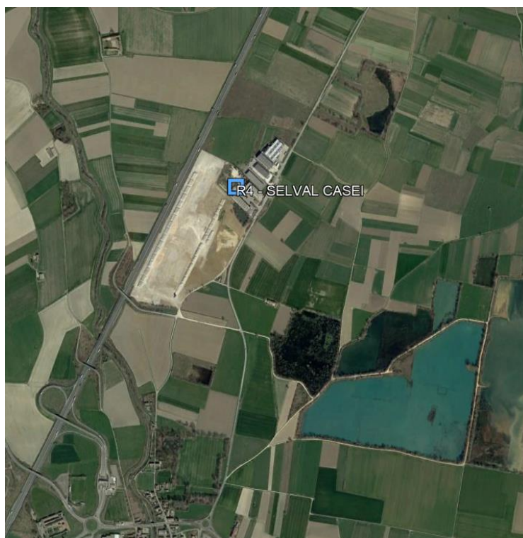
Figura 6: Foto aerea dell'impianto di Casei Gerola (PV)
