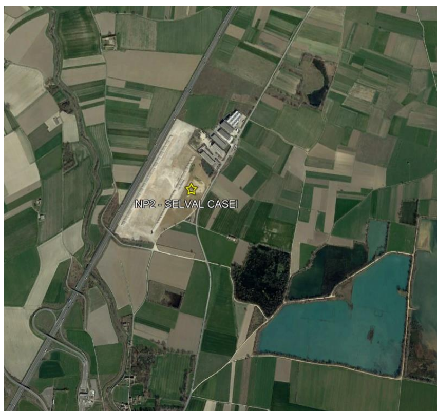
Figura 12: Foto aerea dell'impianto di Casei Gerola (PV)
