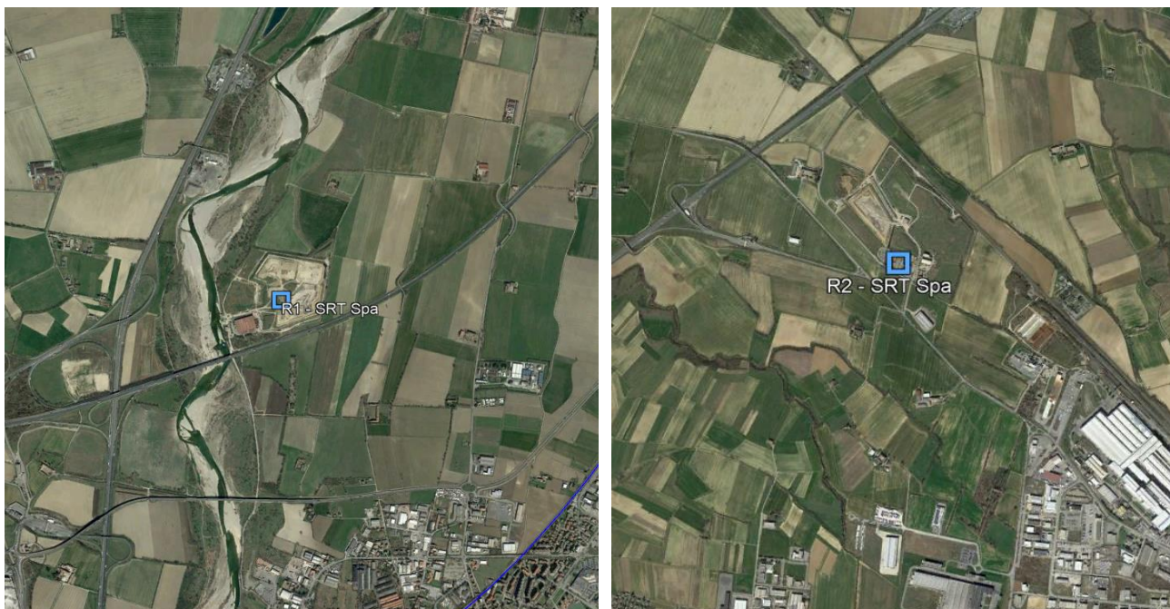
Figura 5: SRT Spa Impianti di Tortona (sx) e Novi Ligure (dx) Foto aerea.
