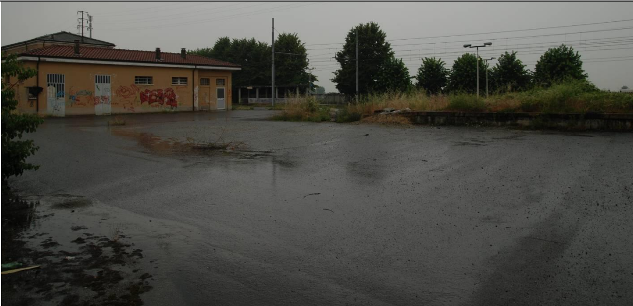
Vista dell'Area Tecnica AT02 dalla stazione di Pontecurone
