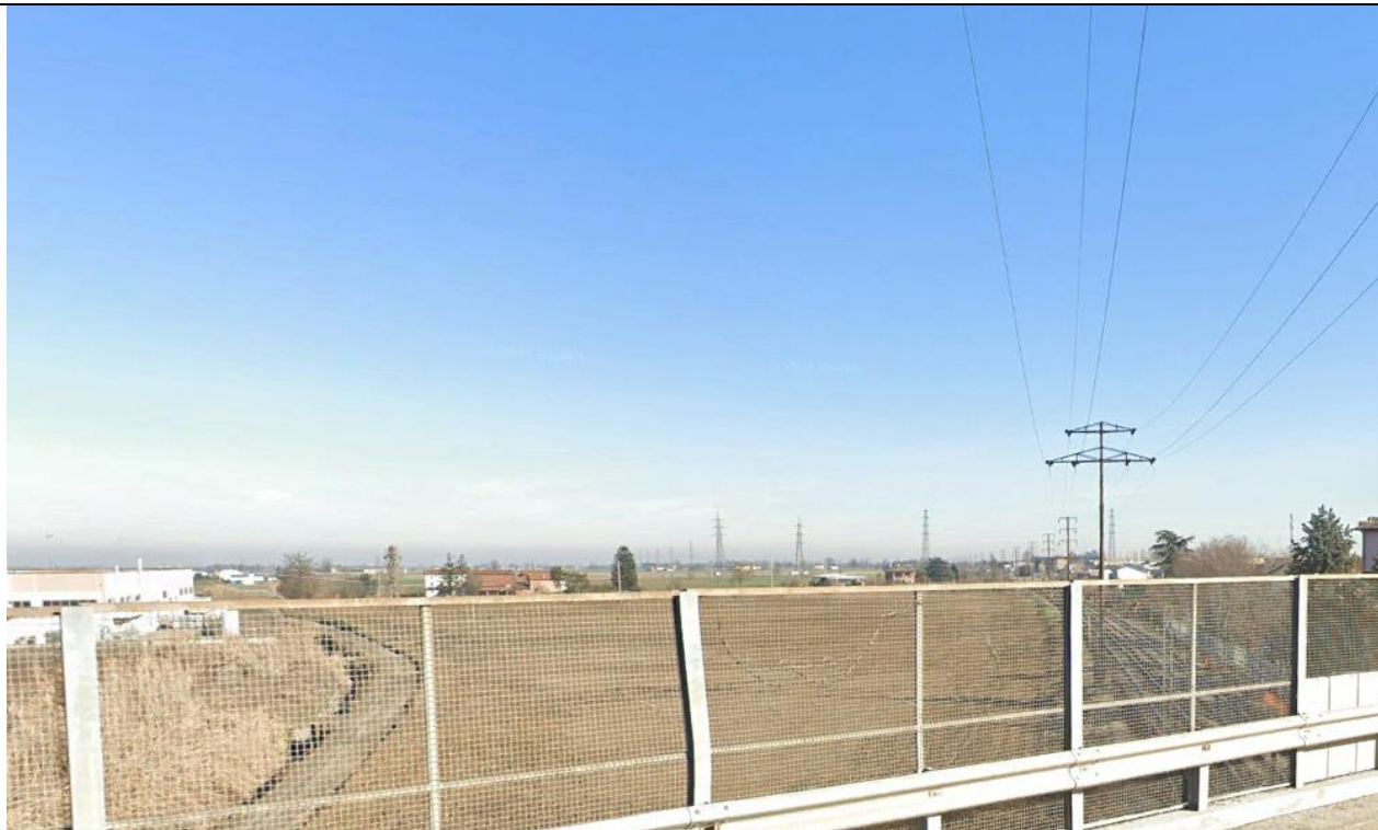
Vista dell'area di stoccaggio AS-01 dal cavalcaferrovia della SR 10
