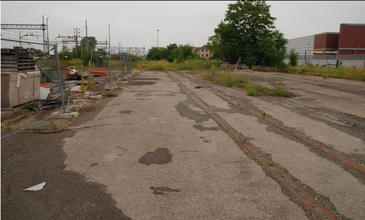
Vista dell'area destinata al cantiere CAT-03
