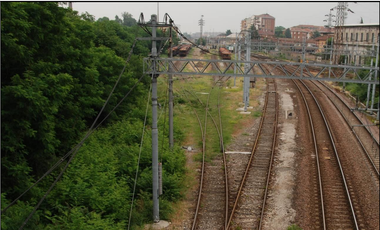
Vista dell'area di cantiere CAT-01, attualmente occupata dai binari di scalo, dal cavalcaferrovia della strada statale per Voghera
