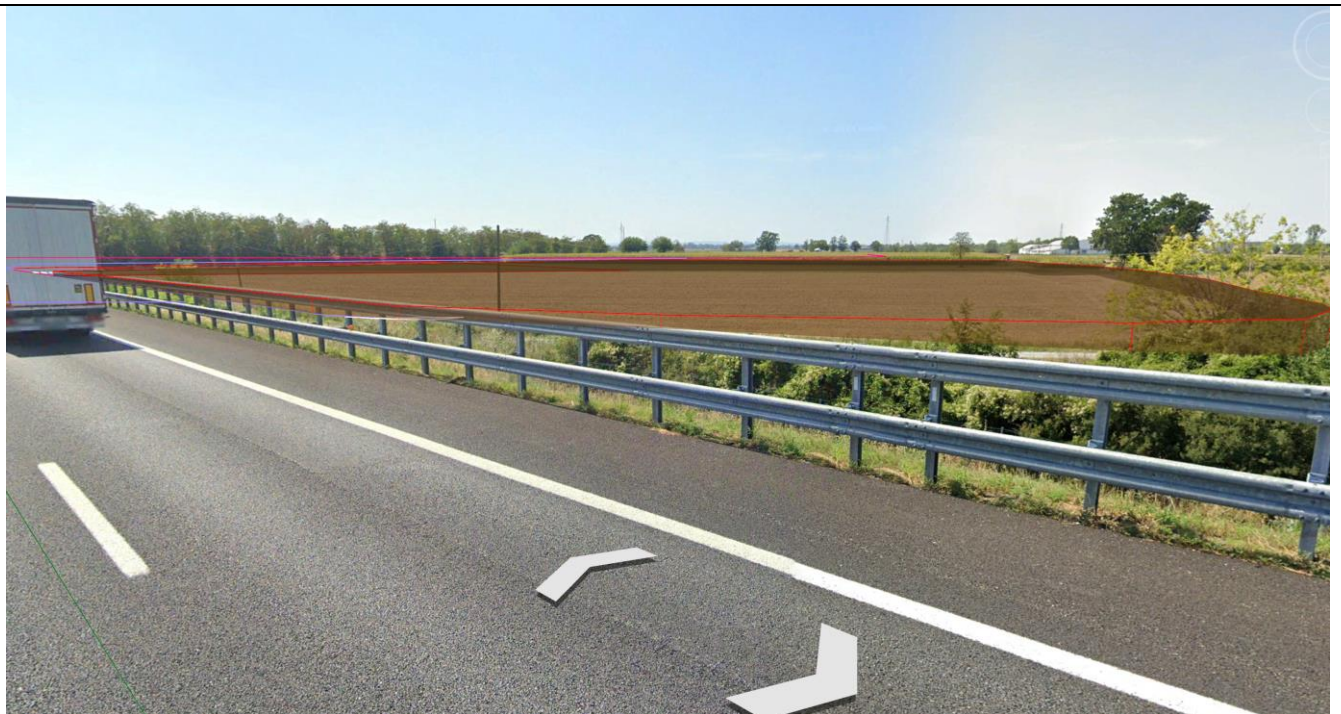
Vista del cantiere di deposito temporaneo DT01 dalla A21
