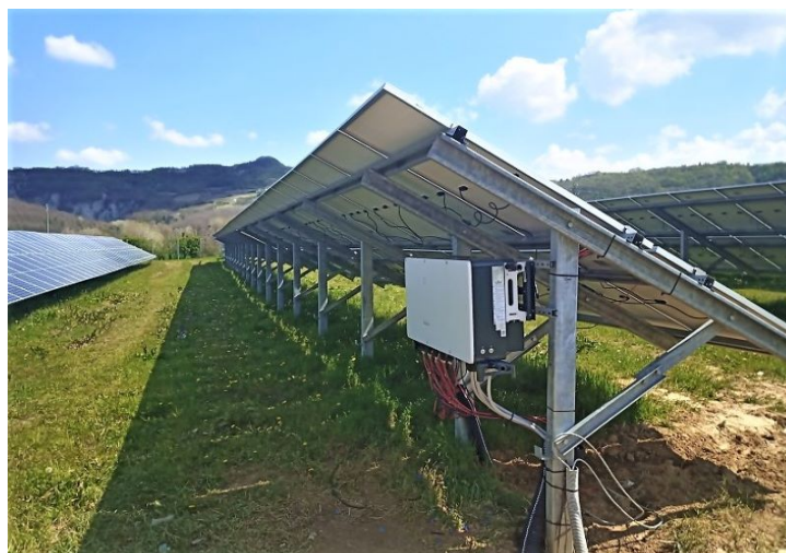
Immagine di esempio del collocamento dell'inverter
