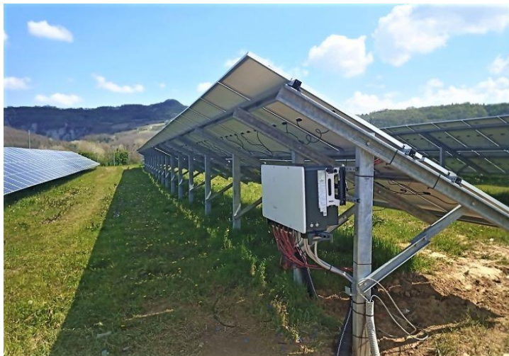
Figura 2-3 Immagine di esempio del collocamento dell'inverter
