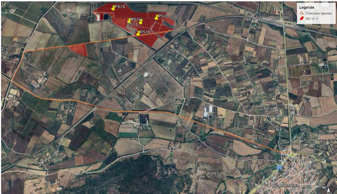
Foto 2 – Zona 4 accesso e Power Station
